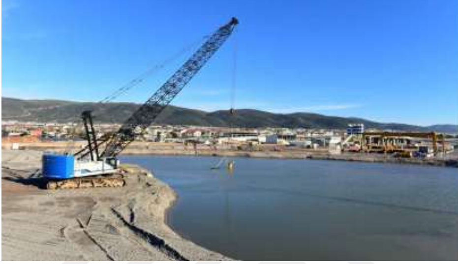
Şekil 5.11. Toyo Pompa ile Malzeme Çekilmesi
