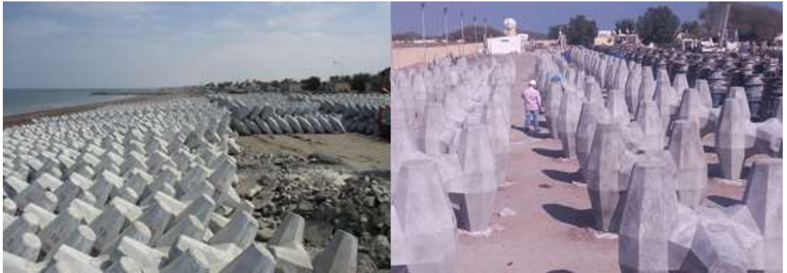
Şekil 5.21 Armour Rock yerine kullanılan Corelocların Görünümü
