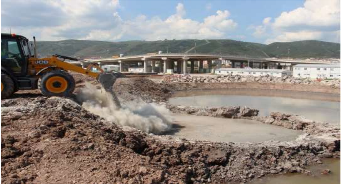
Şekil 5.7. Sönmemiş Kireç Atımından Görünüm
