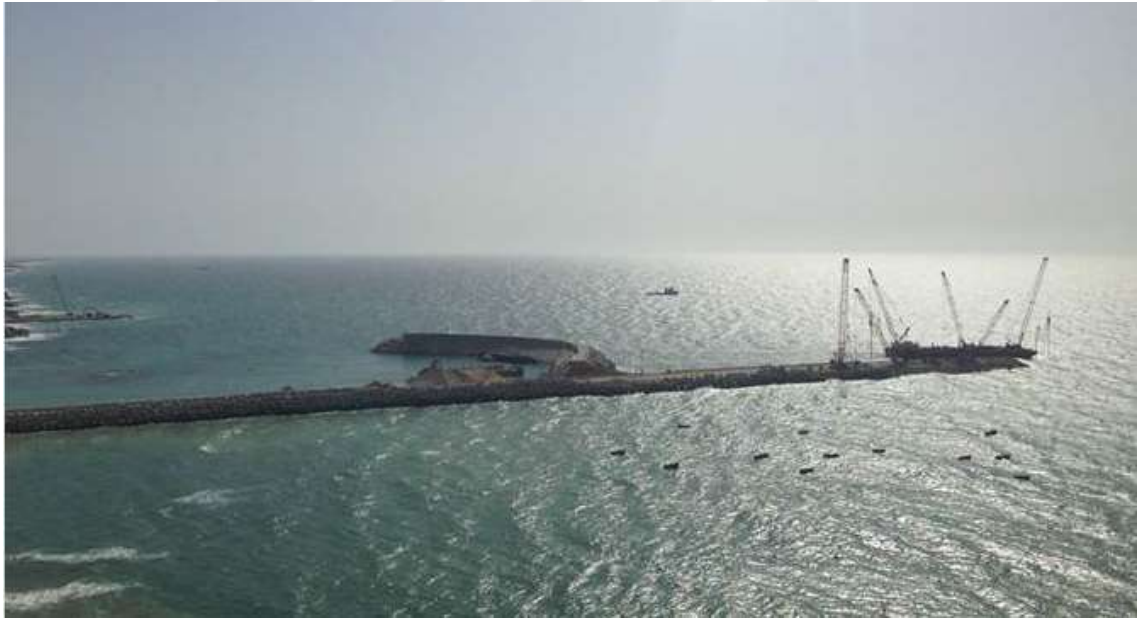
Şekil 5.18 Safi Limanı Kara Ekipmanları ile Taş Yerleştirilmesi
