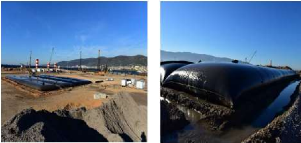
Şekil 5.15 Tüplere Malzeme Basılması ve Nihayi Bekleme
