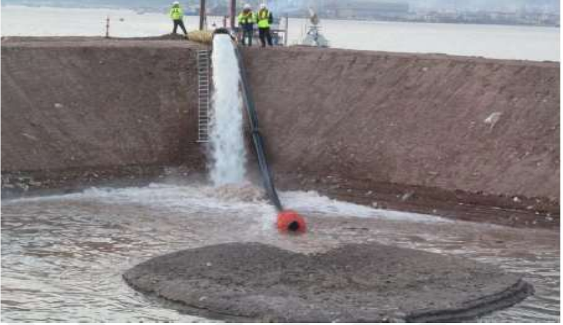
Şekil 5.4. Yapımı Tamamlanan Büyük Havuza Taramadan Gelen Malzeme Pompalanması
