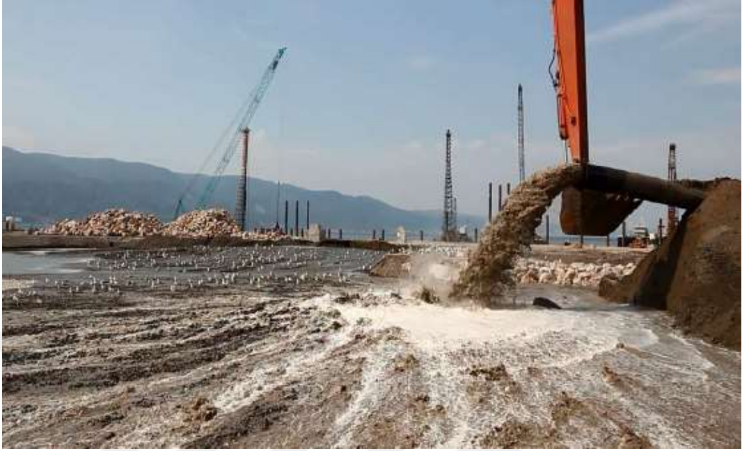
Şekil 5.9. Tarama Dubasından Malzeme Basımı
