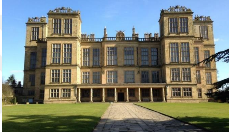
Şekil 2. 6 Hardwick Hall cephesi [23]
