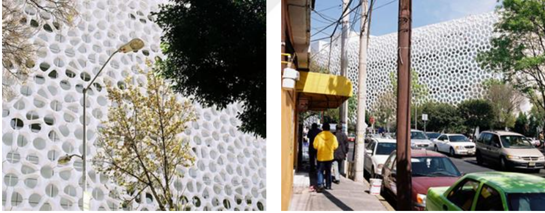
Şekil 4.9 TiO_2 katkılı beton, Manuel Gea Gonzalez Hastanesi cephesi [111][110]
