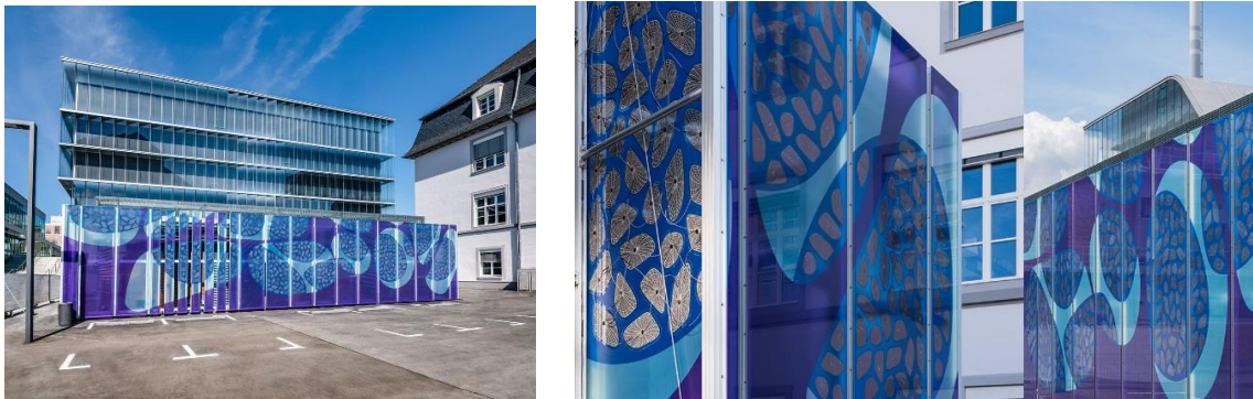
Şekil 4.39 MERCK KGaA binası güneydoğu cephesi [149]
