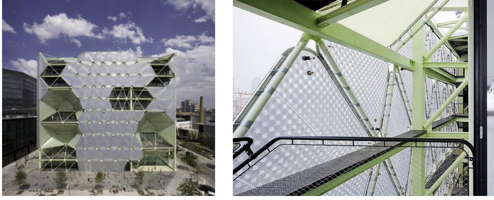
Şekil 3.2 MEDYA-TIC binası cephesi [48]
