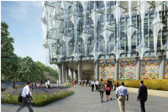
Şekil 4.37 U.S. Embassy cephesi, ETFE üzerine PV entegrasyonu [146]
