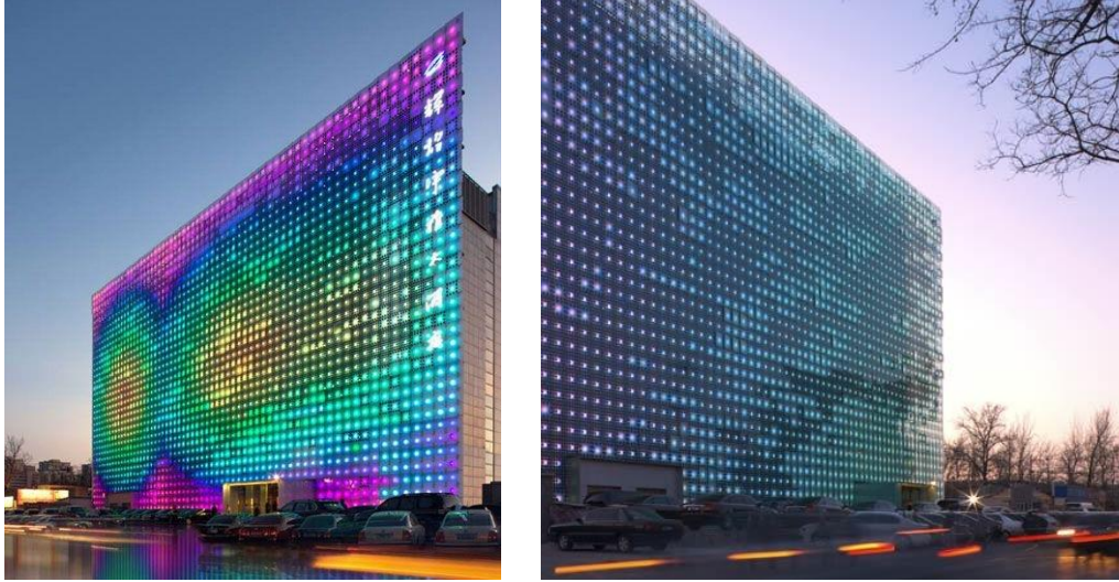
Şekil 4.55 GreenPix Zero Energy Medya Duvarı cephesi [179][180]
