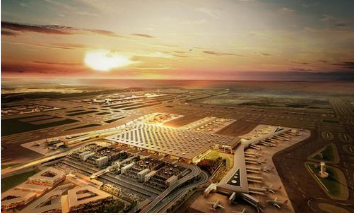
Şekil 5. 21 İstanbul Havalimanı Genel Görünüm [203]
