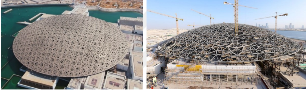
Şekil 2.2 Tek ve çift tabakalı uzay kafes sistemin birleşik örneği; Abu Dhabi Louvre Müzesi, BAE [7][8]
