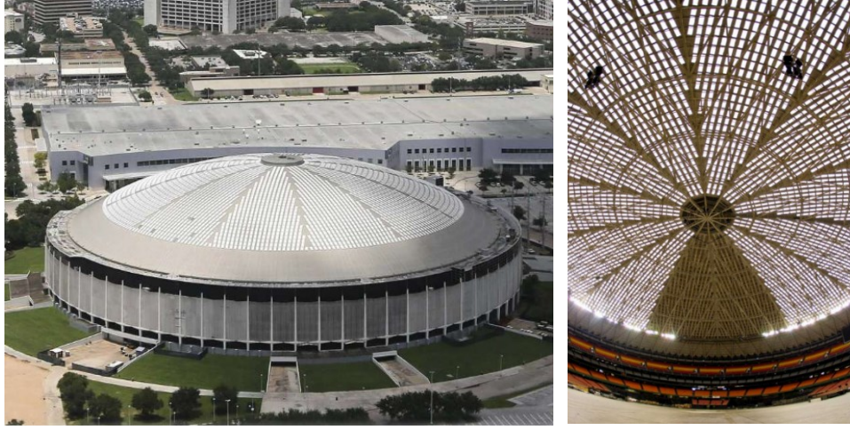
Şekil 2.21 Diamatik lamella kubbe örneği; Houston Astrodome, Teksas [38]
