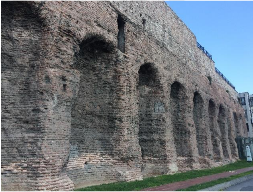
Şekil 4.22 Zeyrek Sarnıcı duvarı [44]
