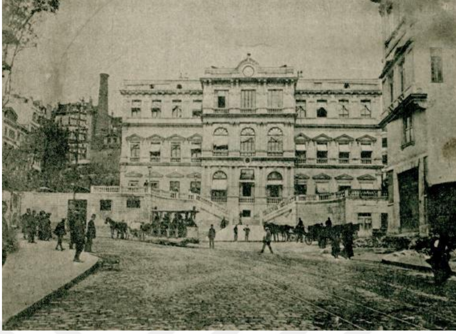
Şekil 4.29 “İstanbul’da asar-ı ümran: Beyoğlu’na çıkan Altıncı Daire caddesinin tramvay şirketi tarafından tevsi ve tesviyesi” [SF, 1042: Kp]
