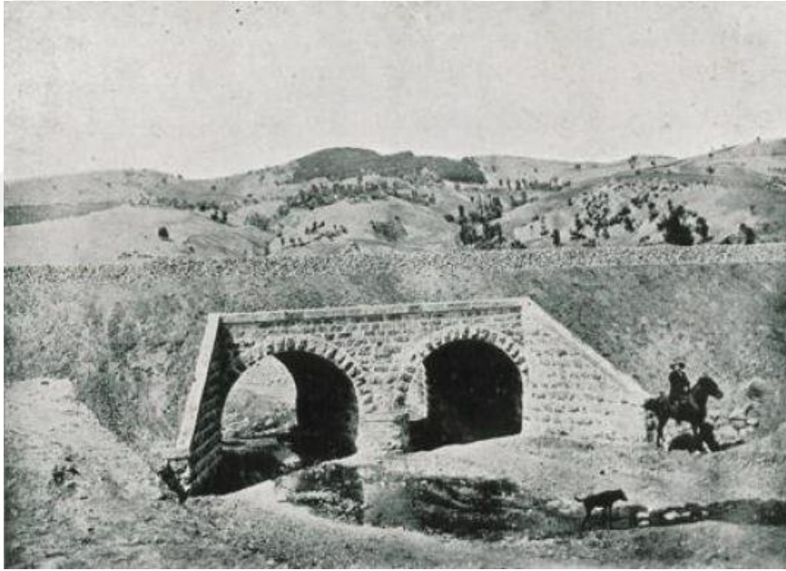
Şekil 4.40 " Türk mühendislerinin vukuf ve irfanı hakkında vesikalar " " Samsun -Sivas demiryolunun köprülerinden biri " [Ş, 81: 167]
