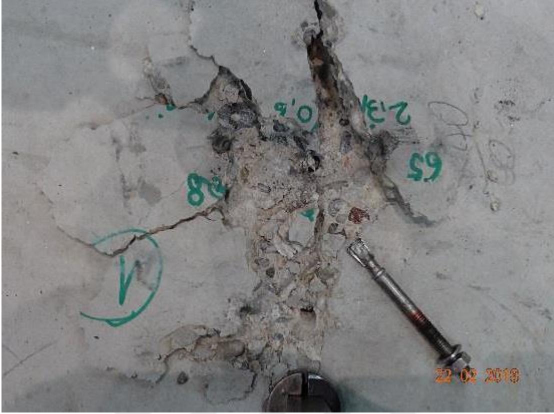
Şekil 2.20 Yorulma testinde çelik hasarı
