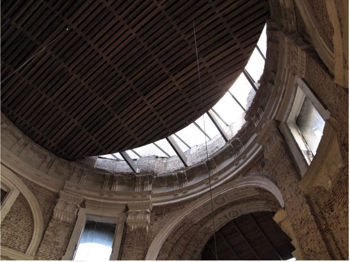
Şekil 2.6 Escuelas Pias de San Fernando Kilisesi, Çatı [80]
