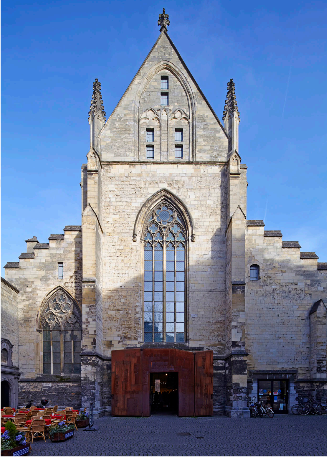
Şekil 4.29 Selexyz Dominicanen, Cephe [141]
