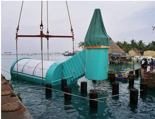
Şekil 5.10 Ithaa Su Altı Restoranı, yapının su altına yerleştirilmesi ve girişi [116]
