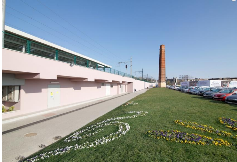
Şekil 3.7 Kazlıçeşme Marmaray istasyonu İSPARK otoparkı ve istasyon girişi
