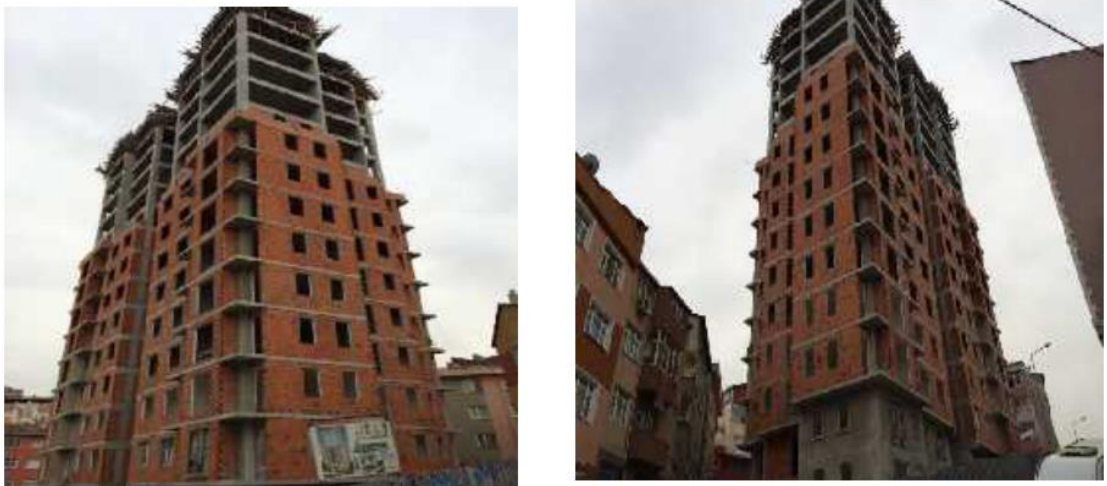
Şekil 4.46 5031 yapı adası dönüşüm sürecinde inşaat aşamaları (Kurt, 2014)
