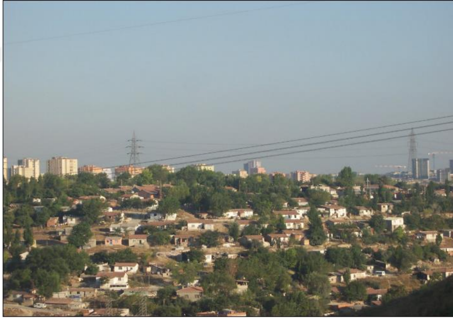
Şekil 4.6 Ayazma bölgesi tasfiye edilmeden önceki durumu (Gervan, 2013)
