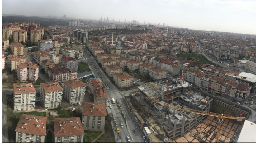
Şekil 4.31 Mevlana Mahallesi kentsel dönüşüm projesi yıkım ve inşaat aşaması (Gaziosmanpaşa Belediyesi, Kentsel Dönüşüm Müdürlüğü, kişisel görüşme, 06 Mart 2019)
