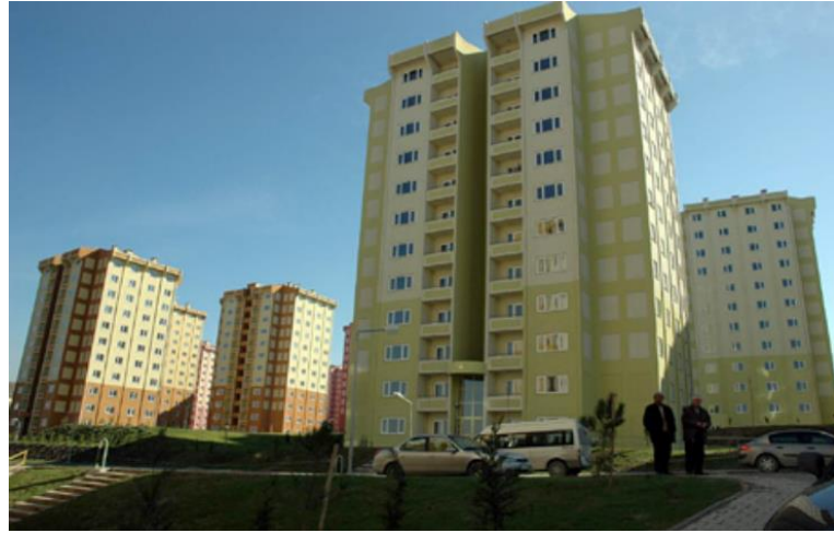
Şekil 4.9 Ayazma dönüşüm projesinde yaşayanların taşındığı Bezirganbahçe konutları (Gervan, 2013)
