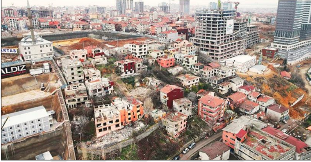
Şekil 4.19 Fikirtepe dönüşüm öncesi, yıkım anı ve dönüşüm sonrası inşaat aşamalarının görüntüsü (Fikirtepe ‘Kat’lanarak Büyüyor, 2019)
