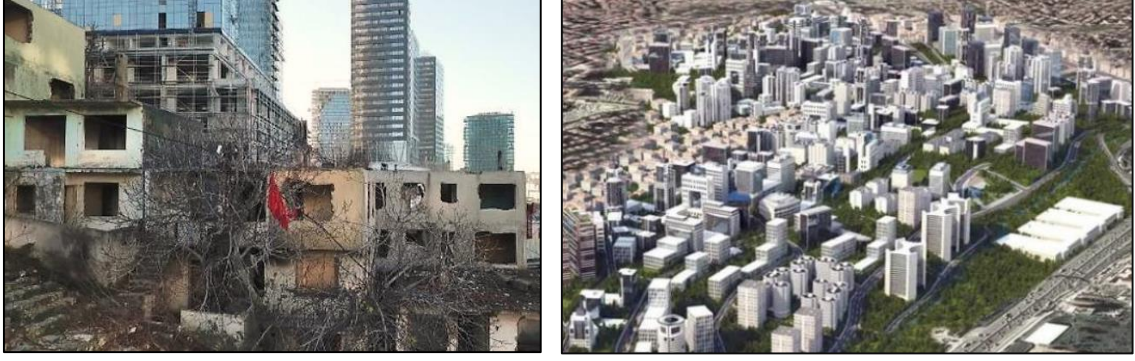
Şekil 4.21 Fikirtepe dönüşüm projesi öncesi ve dönüşüm süreci tamamlandığında elde edilecek kentsel doku (Fikirtepe’de Kentsel Dönüşümün 5 Yıllık Mağdurları, 2019; Fikirtepe Kentsel Dönüşüm ile Değerleniyor, 2019)
