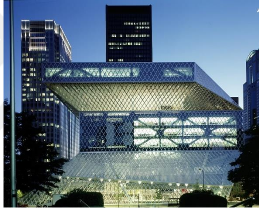
Şekil 2.18 Seattle Merkez Kütüphanesi'nin dış görünüşü [43]
