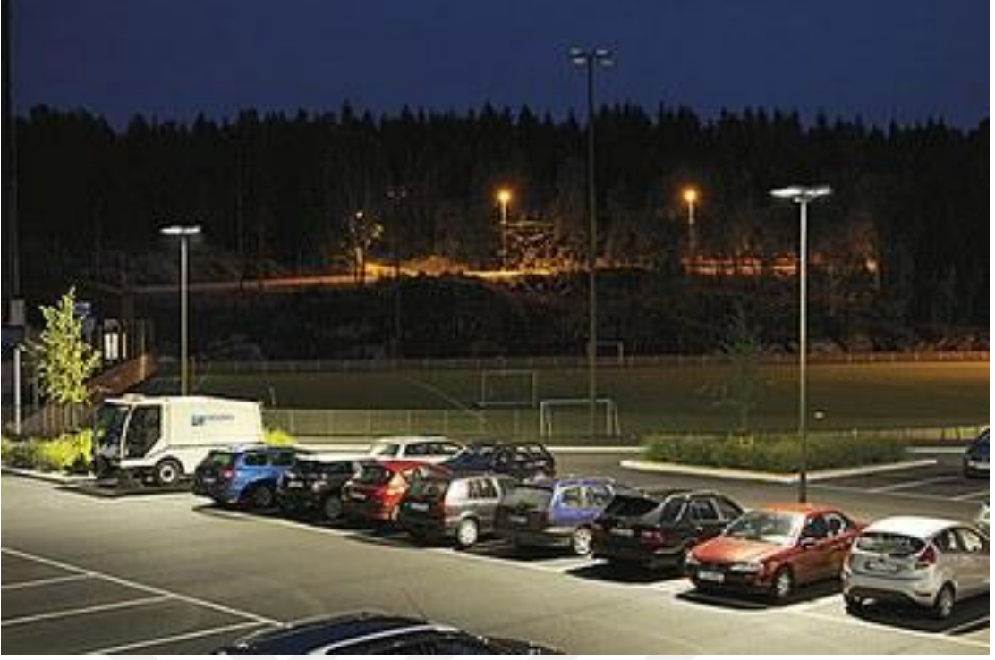
Şekil 3. 11 Açık otoparka aydınlatması örneği [52]
