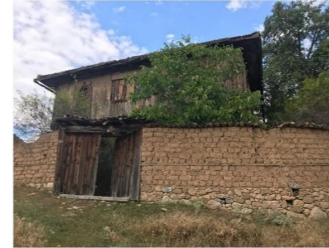
Güney-Batı cephesi görünümü
