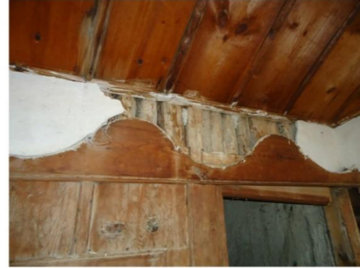
Hayata açılan oda kapılarının üst söve detayları
