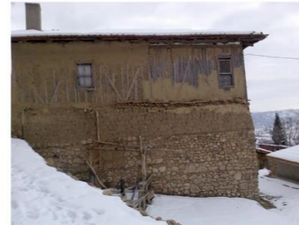
Yapının dış cephesi sıvanmadan önceki hali, 2008
