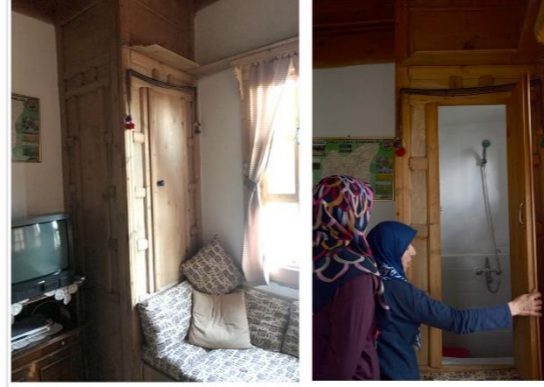
Odanın köşesine konumlandırılmış gusülhane dolabı(sol) ve iç görünümü(sağ)
