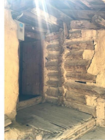
Ahşap yığma sistemin geçme detayı
