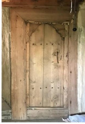
Çakıcıgil evi yaşmaklı oda kapısı
