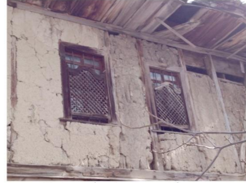
Batı cephesi pencere detayı
