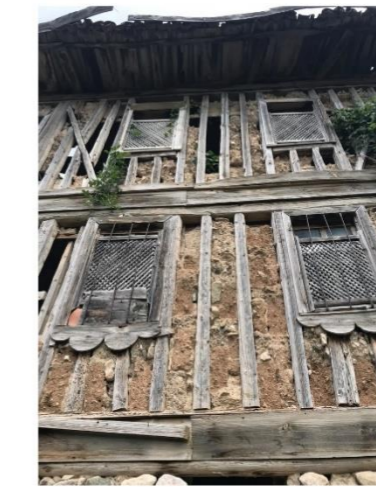
Batı cephesi pencere detayları
