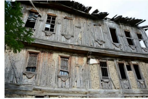
Batı cephesi pencere dizilimi
