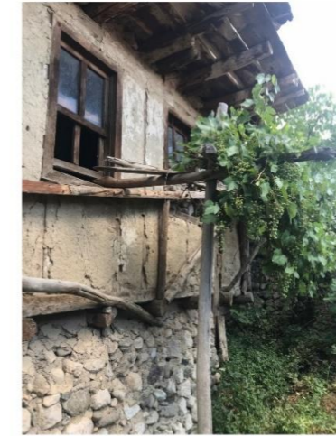
Çakıcıgil evi güney cephesi
