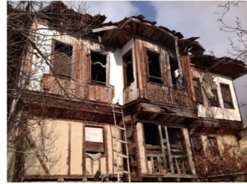
Güney cephesi pencere dizilimi
