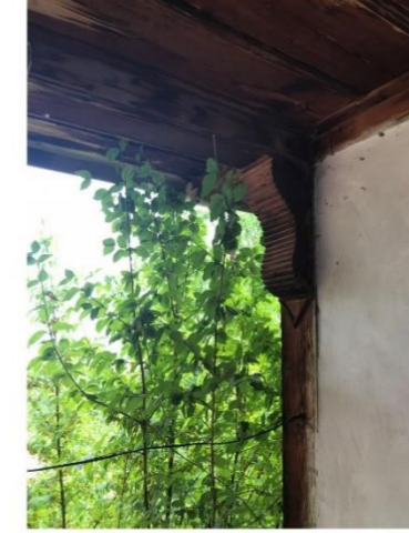
ŞBalkon duvarı ile çatı birleşimindeki ahşap detay
