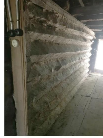
Ahşap yığma sistemin içten görünüşü
