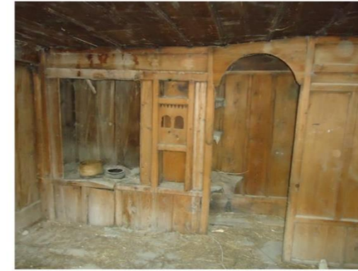
Mutfak girişi ve dolapları
