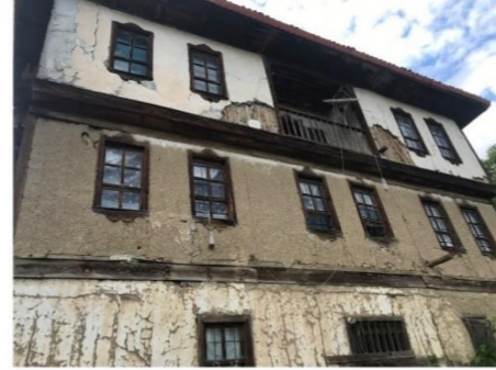
Güney cephesi pencere dizilimi
