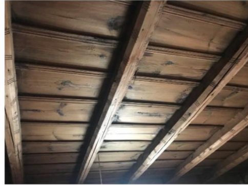
Odalardan birinin ters tavan tekniği ile yapılmış tavan detayı
