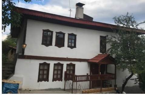
Güney-batı cephesi pencere dizilimi
