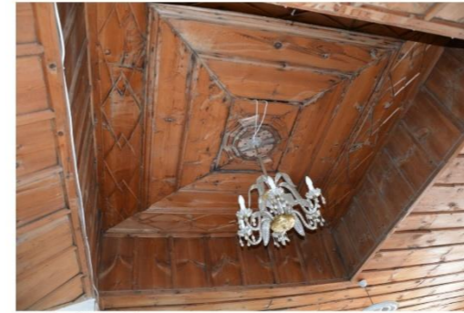
Şihgil evi hayat tavanının tekne tavan tekniği ile yapıldığı görülmektedir, 2018
