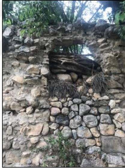
Şekil 4.43 Hamam kalıntısı olduğu söylenen kemerli duvar
