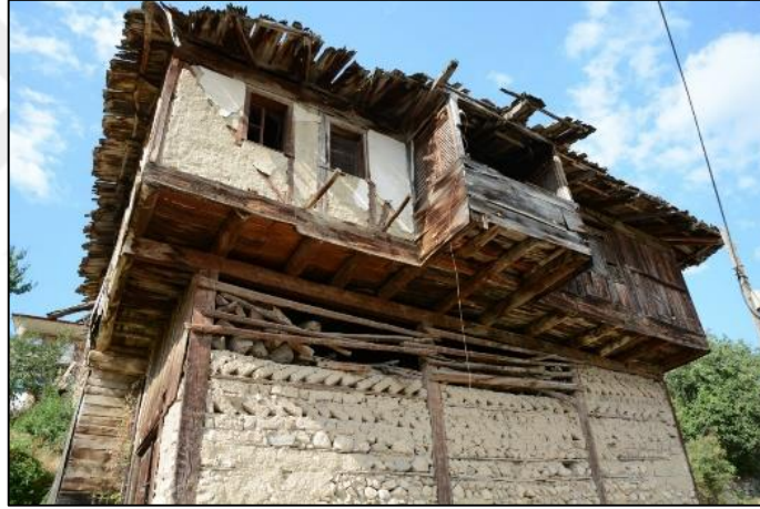
Şekil 4.51 GÜDÜ Kamilegil evi zemin kat duvarında görülen balık kılçığı örme kerpiç tuğlalar görülebilmektedir
