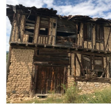
Güney cephesi görünüşü
