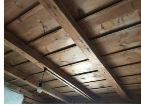
Ahşap kirişler tavan kaplamasının altında
