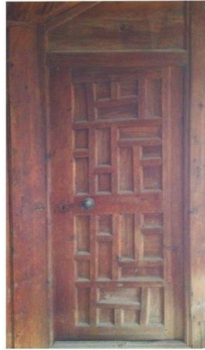
Çitakari teknikle yapılmış ön oda kapısı
