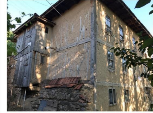
Yapının kuzey cephesinden görünüş, 2017
