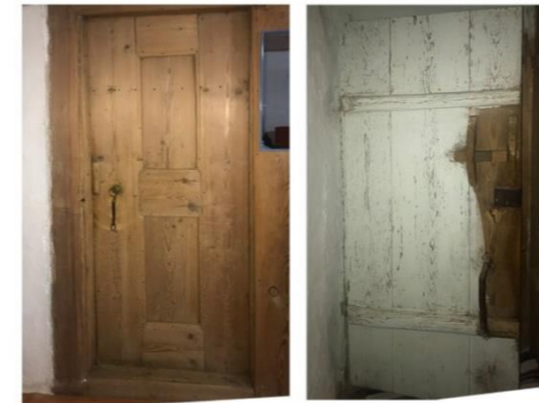
Oda kapısının dıştan (sol) ve içten (sağ) görünüşü
