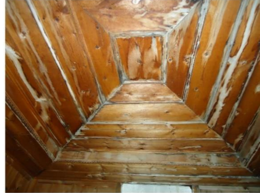
Ön odada tekne tavan uygulaması detayı
