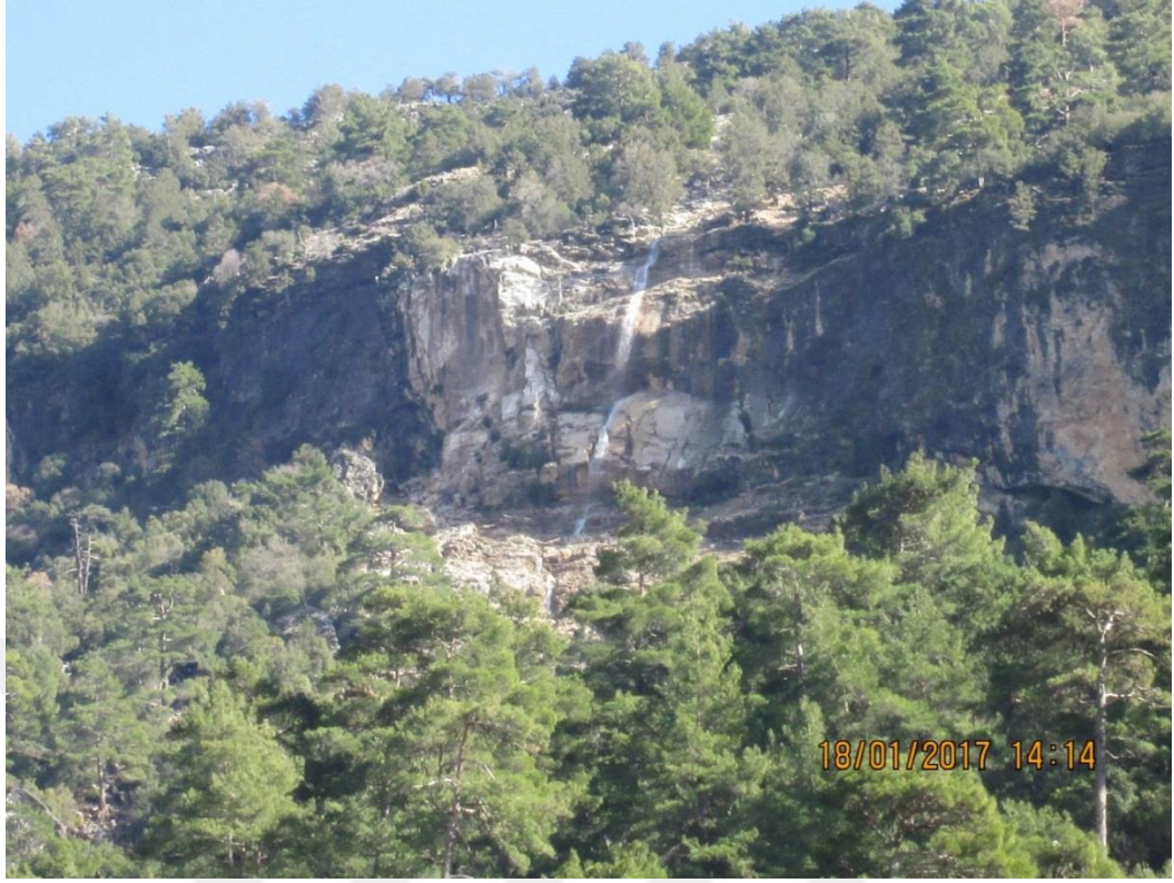
Onur Özden ( Ören HES Barajı)
