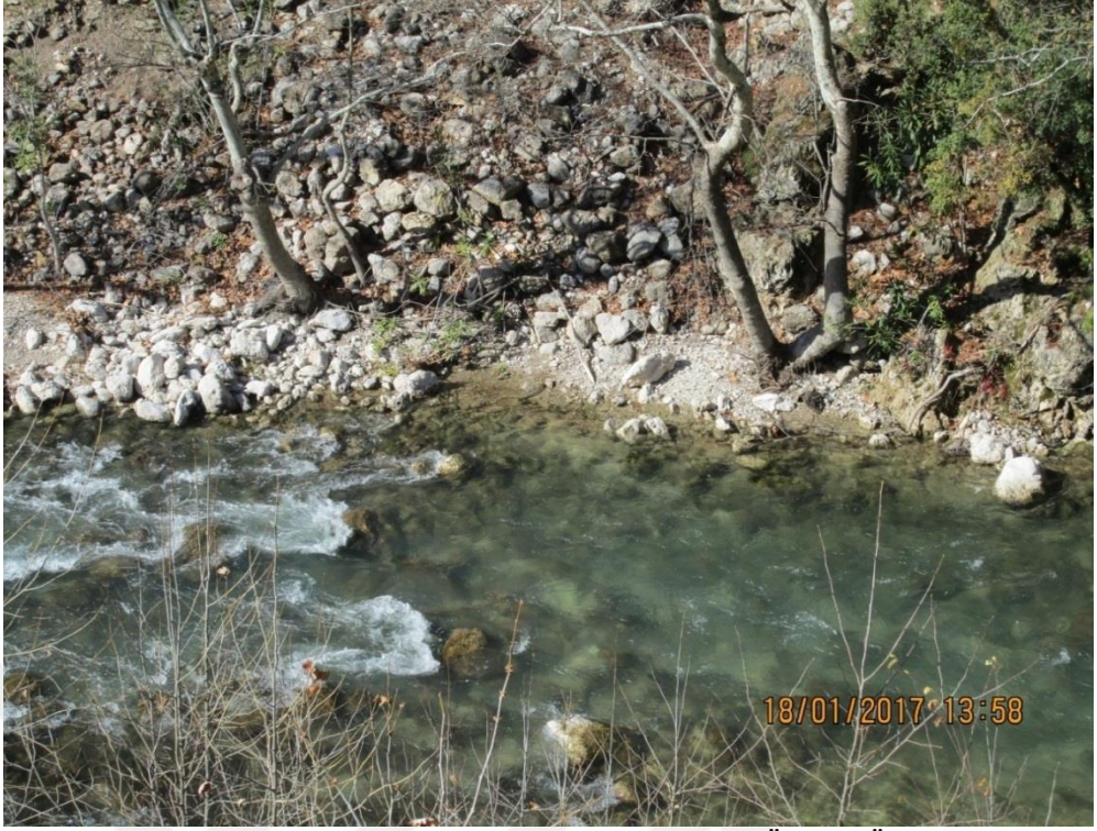
Onur Özden (Ören HES Barajı)
