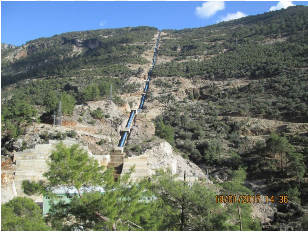
Onur Özden (Ören HES Barajı)
