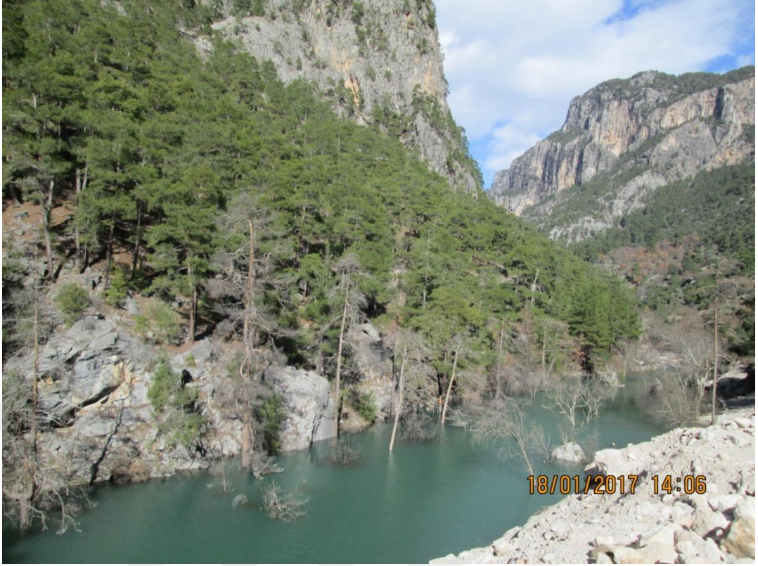
Onur Özden (Ören HES Barajı)
