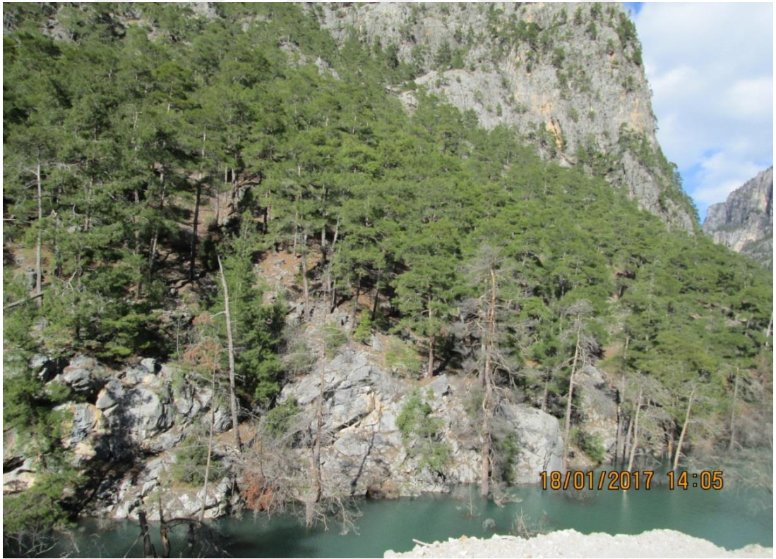
Onur Özden (Ören HES Barajı)
