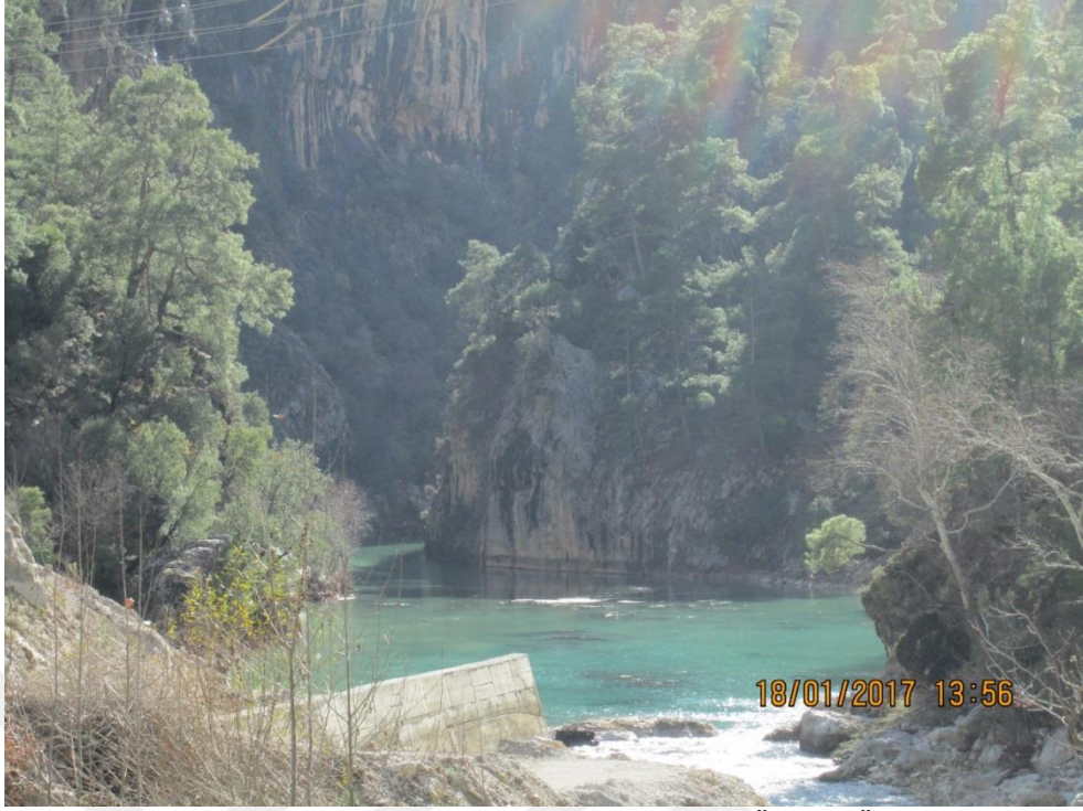
Onur Özden (Ören HES Barajı)
