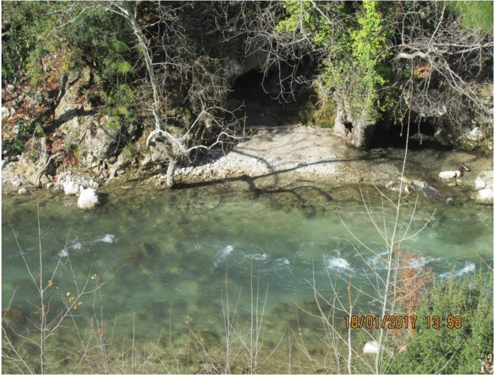
Onur Özden (Ören HES Barajı)
