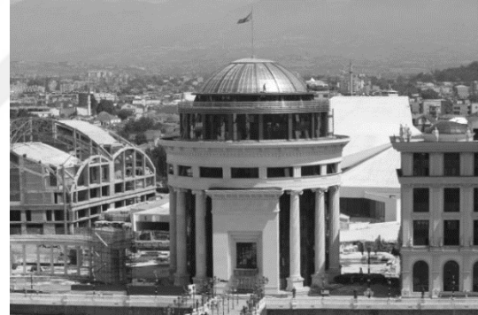
Şekil 4.11 Aynı açıdan Üsküp 2014 Projesi sonrası yapının yakın çevresi (Shulevska, 2015)
