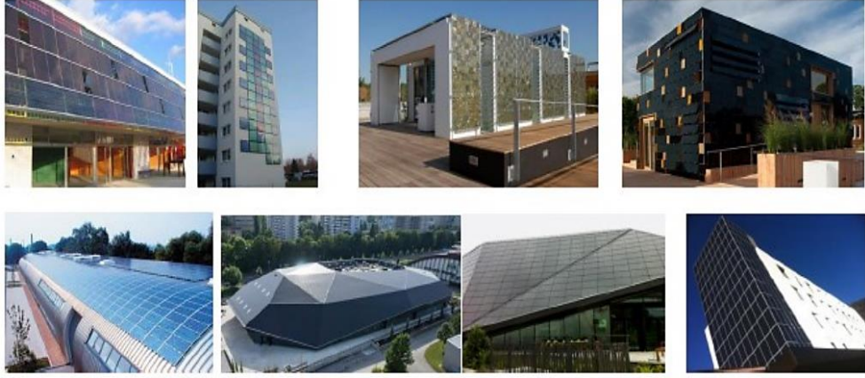
Şekil 1.5. Bina kabuğuna uygulanmış PV uygulamaları (Yılmaz vd., 2015)
