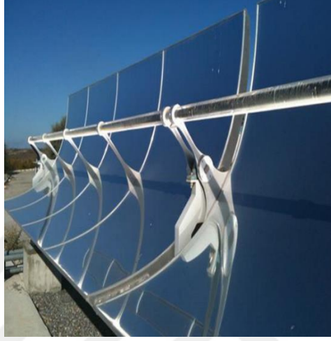
Şekil 4.21. Parabolik oluk toplayıcıları örneği
