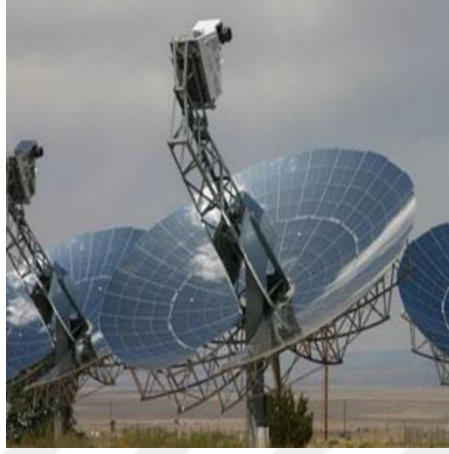
Şekil 4.24. Parabolik çanak toplayıcının görünüşü
