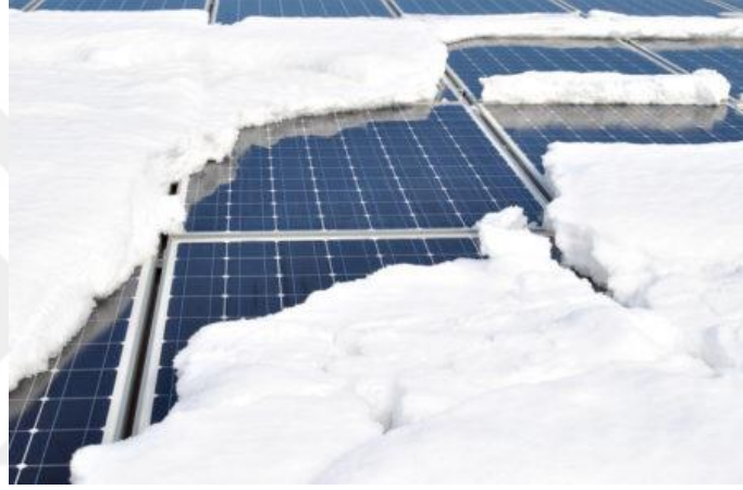
Şekil 6.17. PV istasyonunda kar temizliği
