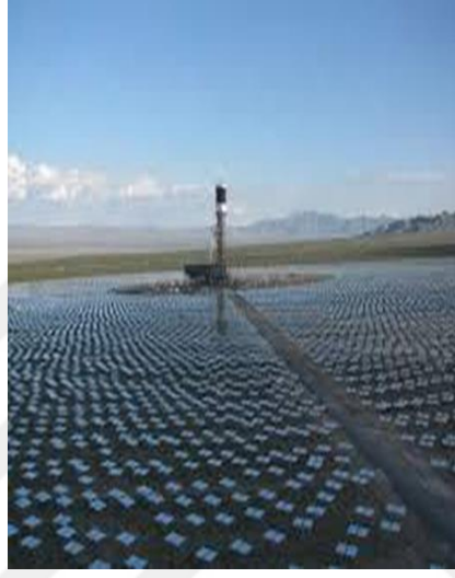
Şekil 4.32. Güneş tarlası uygulaması
