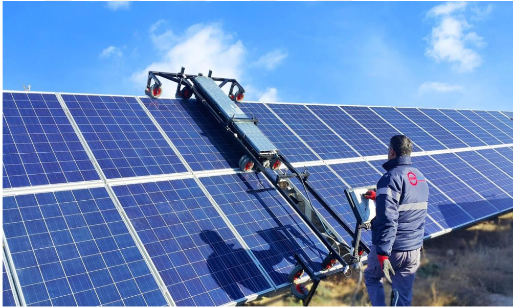
Şekil 6.16. PV temizliği yapılması çalışması
