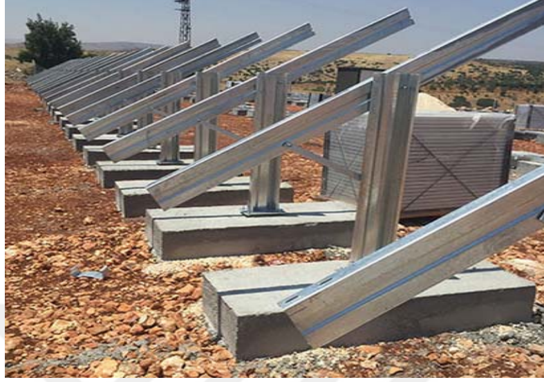
Şekil 3.19. Kalıp beton yöntemi uygulaması (Üçasolar, 2019)
