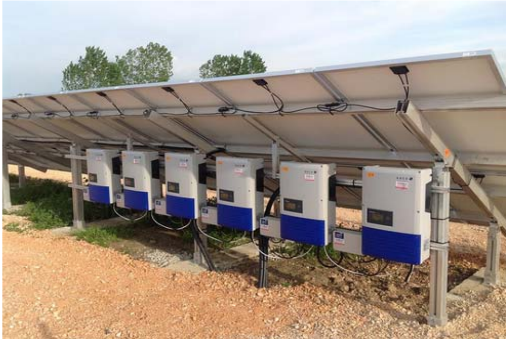
Şekil 3.24. dizi tipi inverter sistemi (Esn, 2019)
