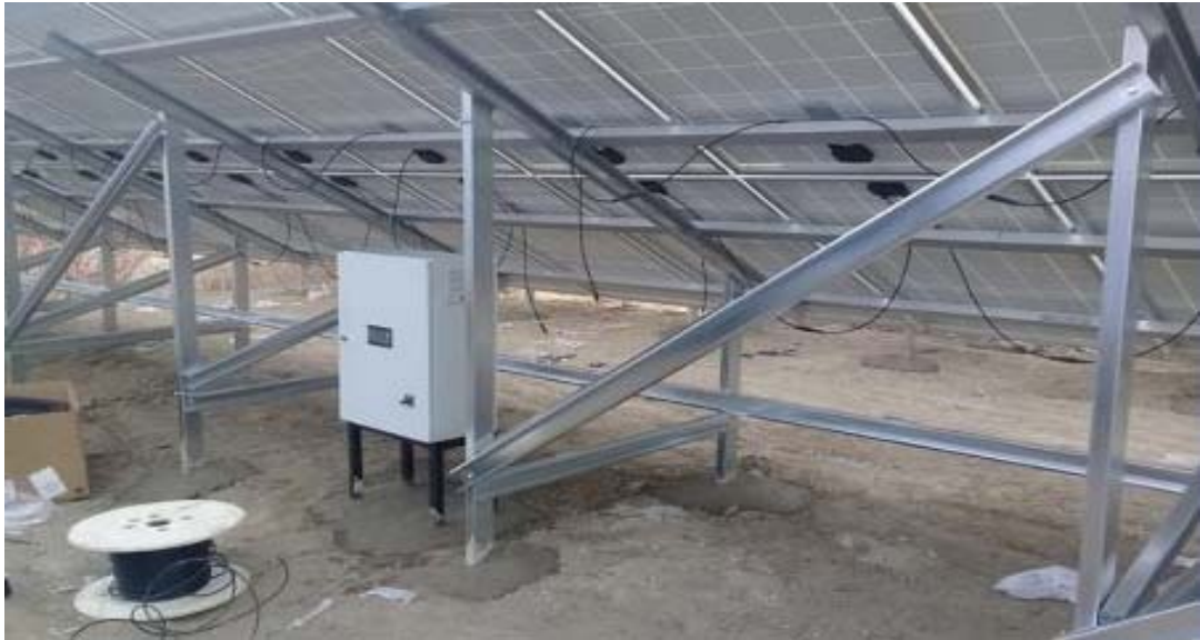
Şekil 3.20. Delme, çakma, beton uygulaması (Solarçelik, 2019)
