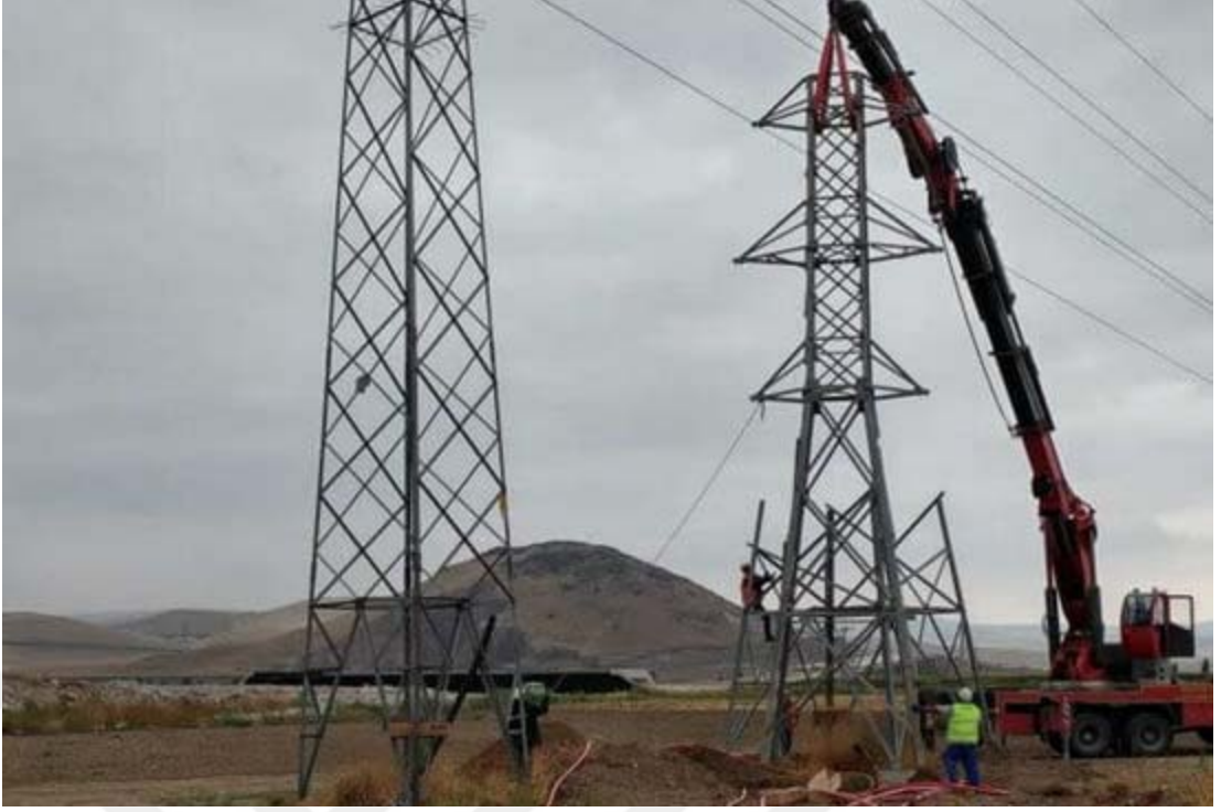
Şekil 3.28. ENH kurulumu (Raven, 2019)
