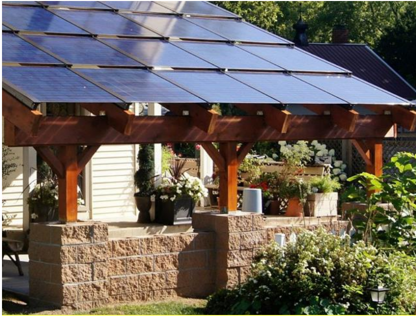
Şekil 4.55 PV sistemlerin Tasarımla Bütünleştirililerek Pergolada Kullanımı
