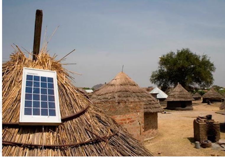
Şekil 4.51 PV sistemlerin Şebeke Olmayan Alanlarda Kullanımı
