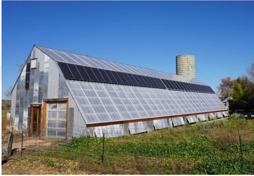
Şekil 4.54 PV sistemlerin Seralarda Kullanımı
