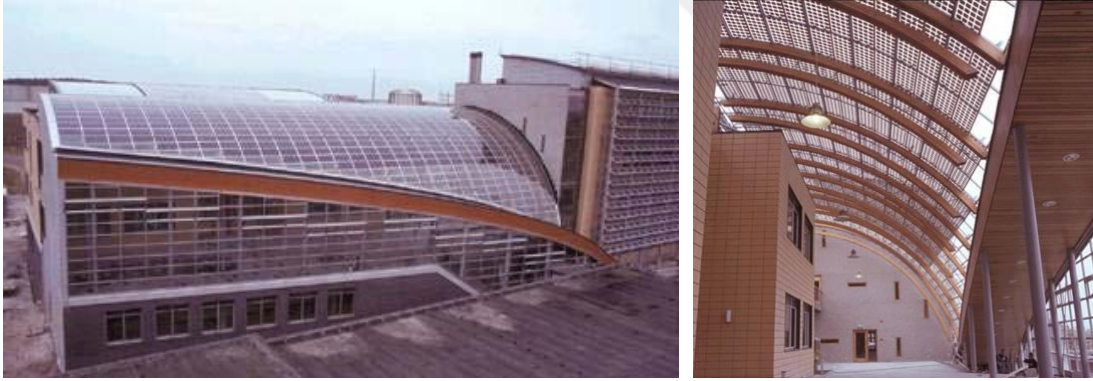
Şekil 4.50 Atriumda PV kullanımı, İngiltere [108].
