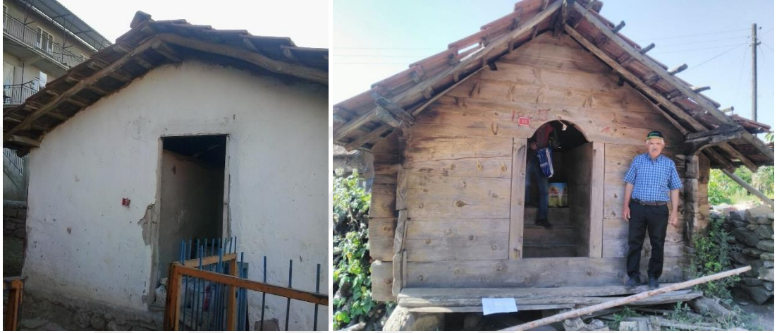
Şekil 3.2. Örneklerin alındığı betonarme ve ahşap depolar
