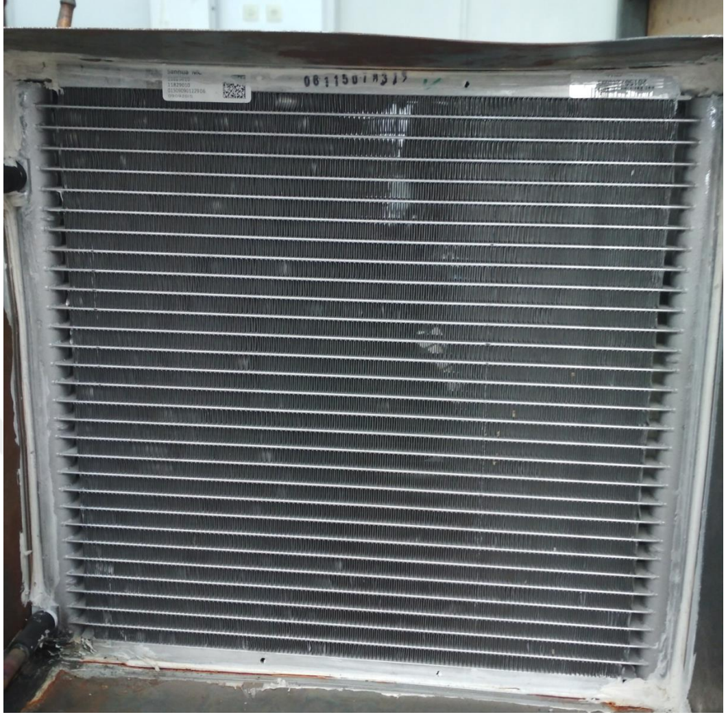
Şekil 5.3. Mikro kanallı buharlaştırıcı.
