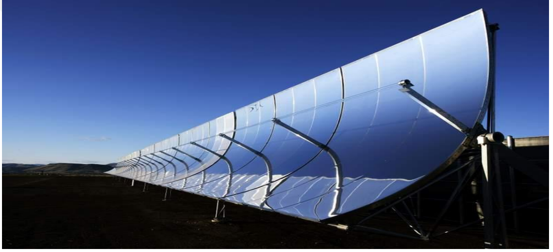
Şekil 3.4. Parabolik oluklu güneş enerji sistemi (Enerji Enstitüsü, 2017)
