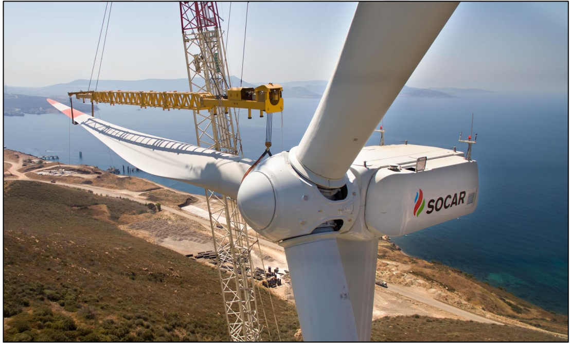
Őekil 3.1. Alstom ECO 110 rzgr trbininin Petkim RES sahasına montajı (Anonim, 2019 b)
