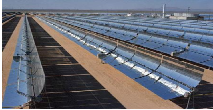
Şekil 1.8. Parabolik oluk tipi kollektörler (Anonim, 2019b)
