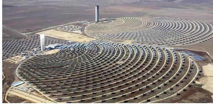
Şekil 1.10. Merkezi alıcılı sistemler: heliostat (YEGM, 2019c)
