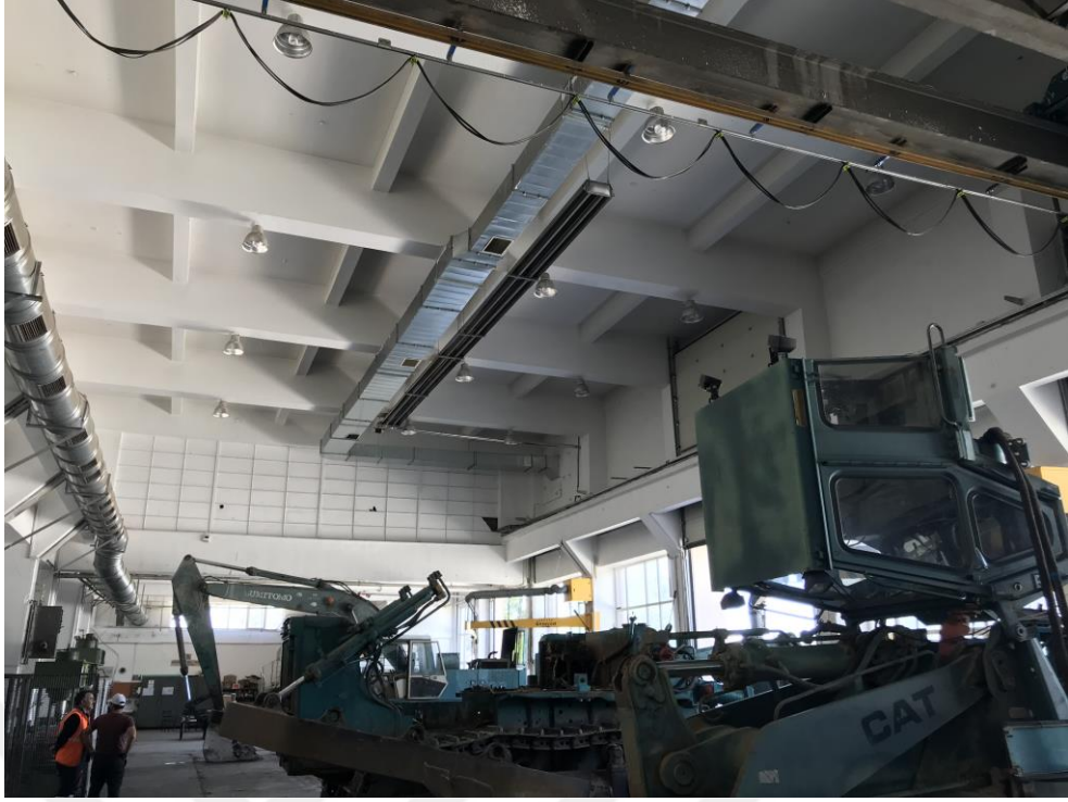
Şekil 3.6. Endüstriyel tesis boru tipi radyant ısıtma
