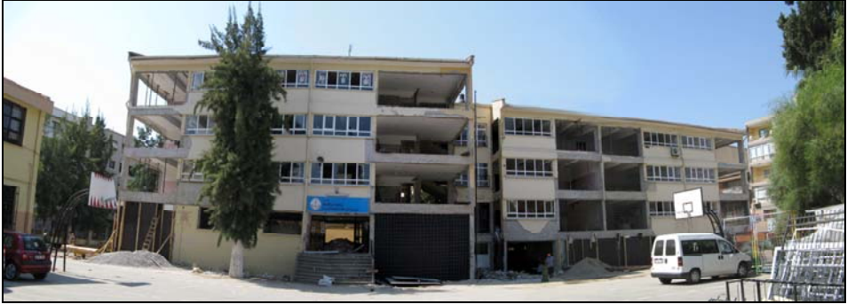
Şekil 4.1.17b. Karşıyaka İlköğretim Okulu eğitim binası güçlendirme çalışmaları.
