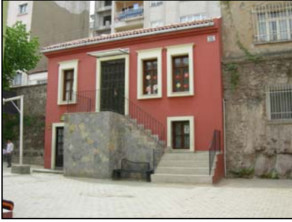
Şekil 4.1.25b. Duatepe İlköğretim Okulu ilk eğitim binası.
