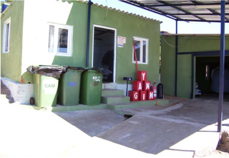
Şekil 4.4. Katı Atık Toplama Tankları
