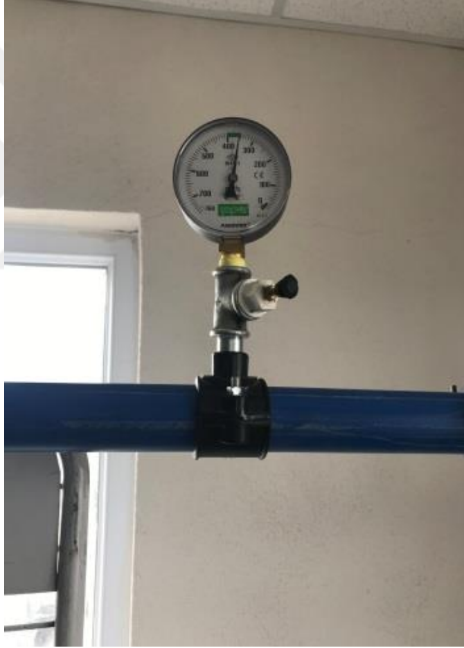
Şekil 3.7. Vakum saati yakınında bağlantı
