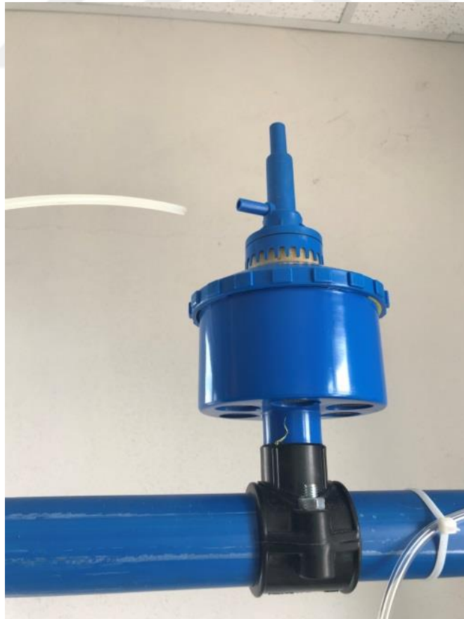
Şekil 3.18. Servo tip regülatör ayar hortumu iptali
