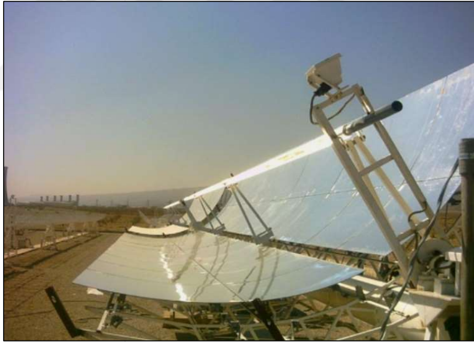
Şekil 3.2. Parabolik oluklu güneş kolektörü (Şanlı,2010)
