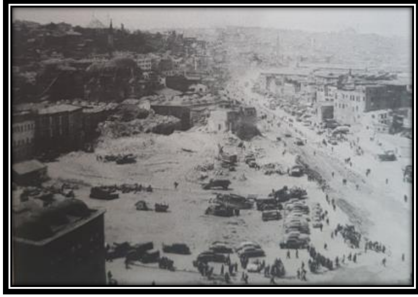
Şekil 5.13 Haliç'in güney kıyısı boyunca uzanan sahil yolunu (Ragıp Gümüşpala Caddesi) yapmak için Eminönü'nün batısında gerçekleştirilen yıkımlar (Gül, M. 2013)
