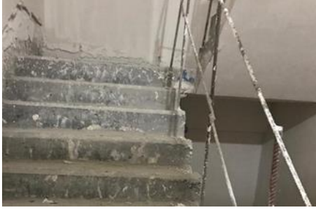
a. Merdiven korkulukları
