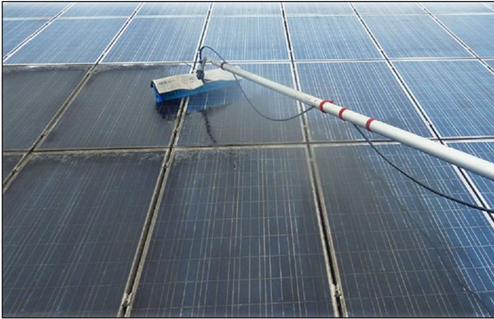
Şekil 4.6. Güneş paneli temizleme mekanizması
