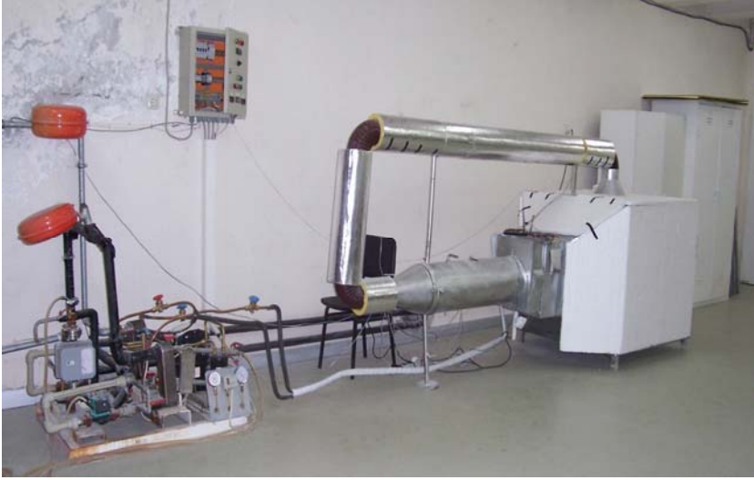
Şekil 6.4 TKIPK sisteminin bütününün görünümü
