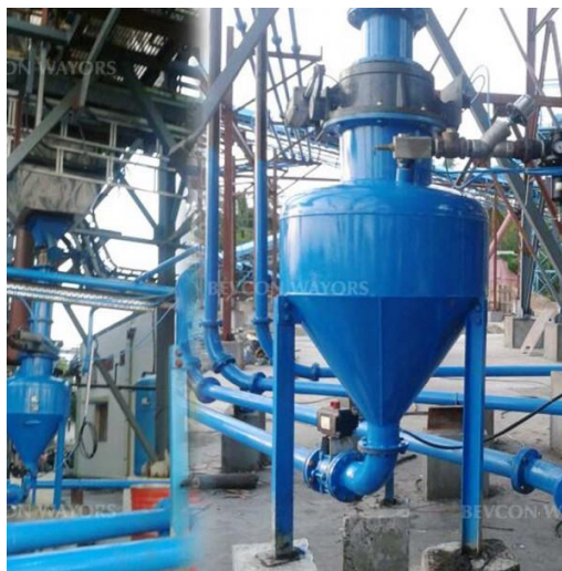
Şekil 5.6 Pnömatik kül taşıma sistemi (Bevcon Wayors, 2019)
