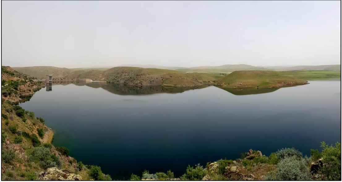
Şekil 4.22. Kesikköprü Barajı, Bala (05.05.2019)
