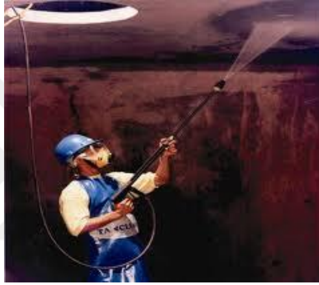
Şekil 3.4. Kimyasal ile Tank Yıkama
