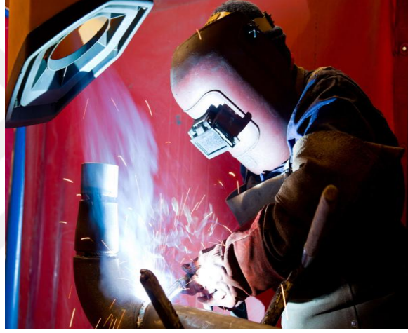
Şekil 5.8 Kesme/Kaynak İşinde Havalandırma
