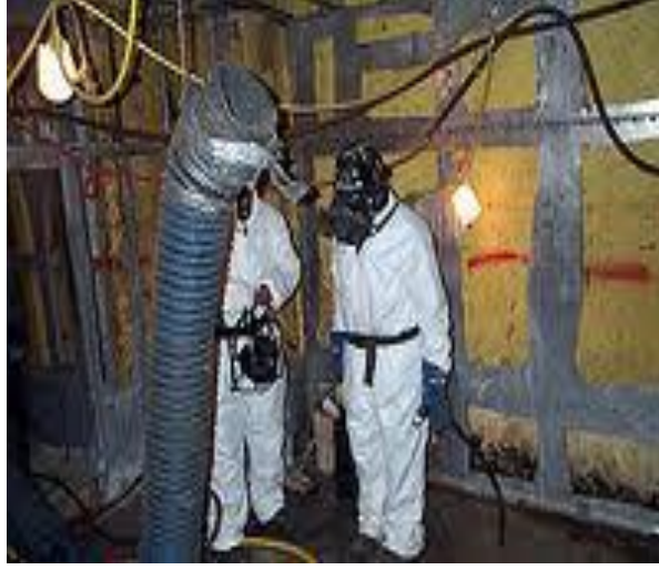
Şekil 5.1. Sıcak İşlem Havalandırma
