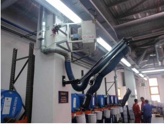
Resim 29 Exproof Isıtma Sistemi
