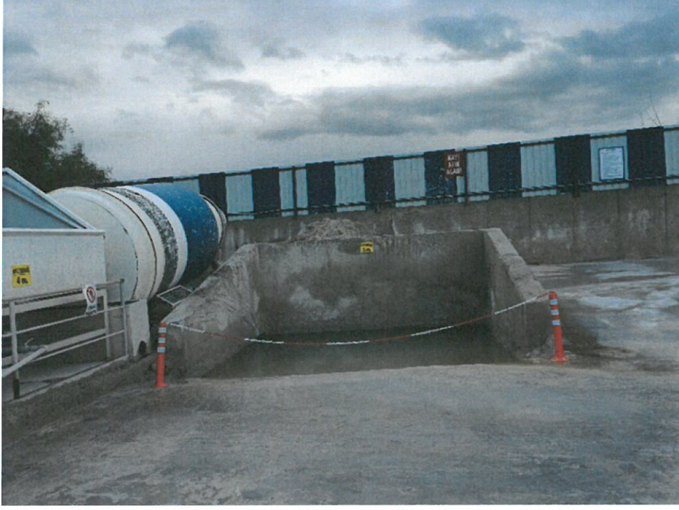
Resim 4: Havuz beton bariyer görüntüsü
