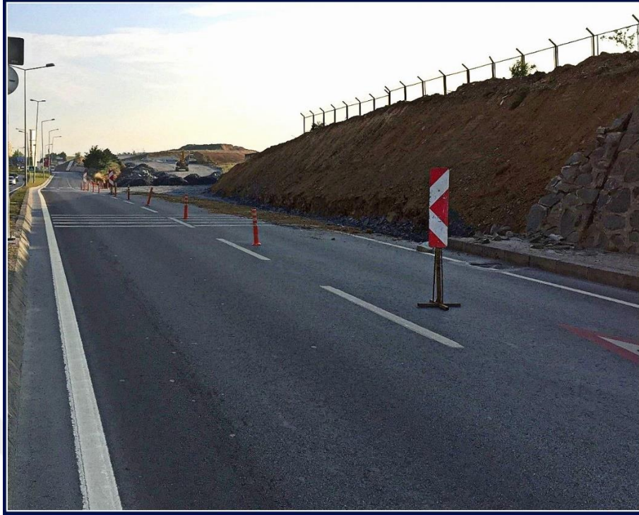
Resim 4; Arnavutky duble yol bakım onarım alıřması
