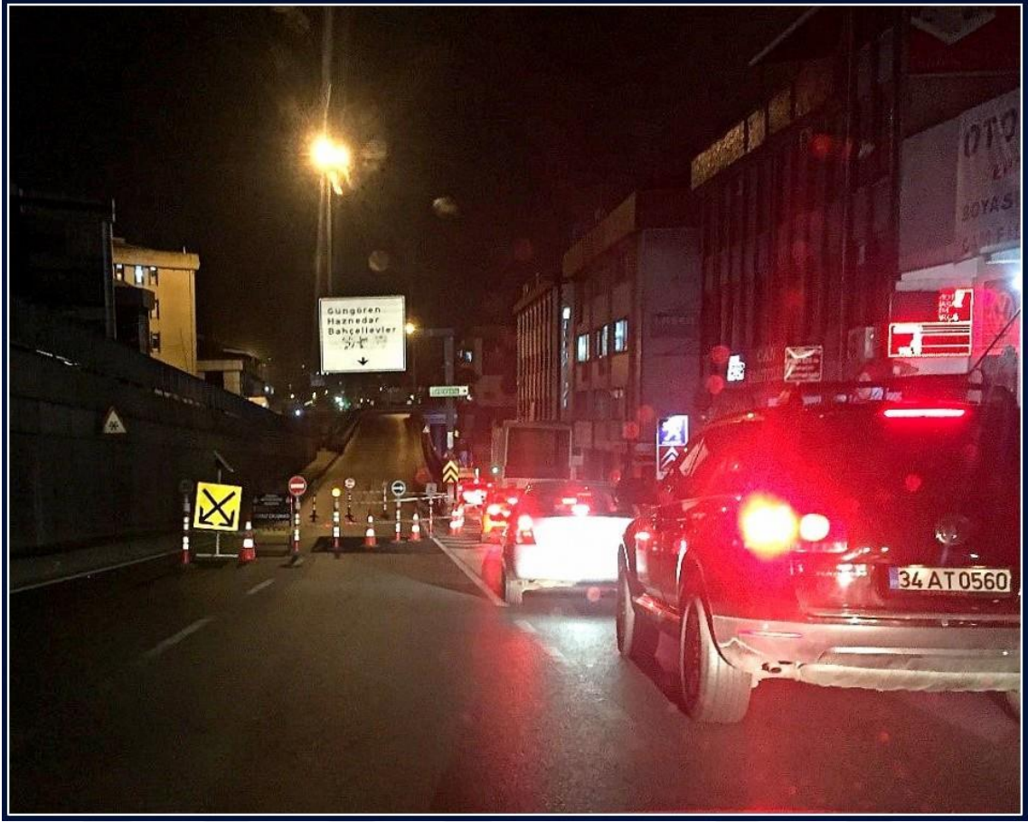
Resim 16; GÜNGÖREN MERTER MEVKİİ ONARIM ÇALIŞMASI
