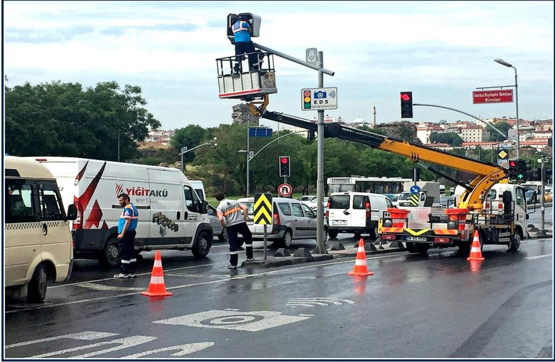
Resim 15; Edirnekapı mevkii sinyalizasyon bakım çalışması
