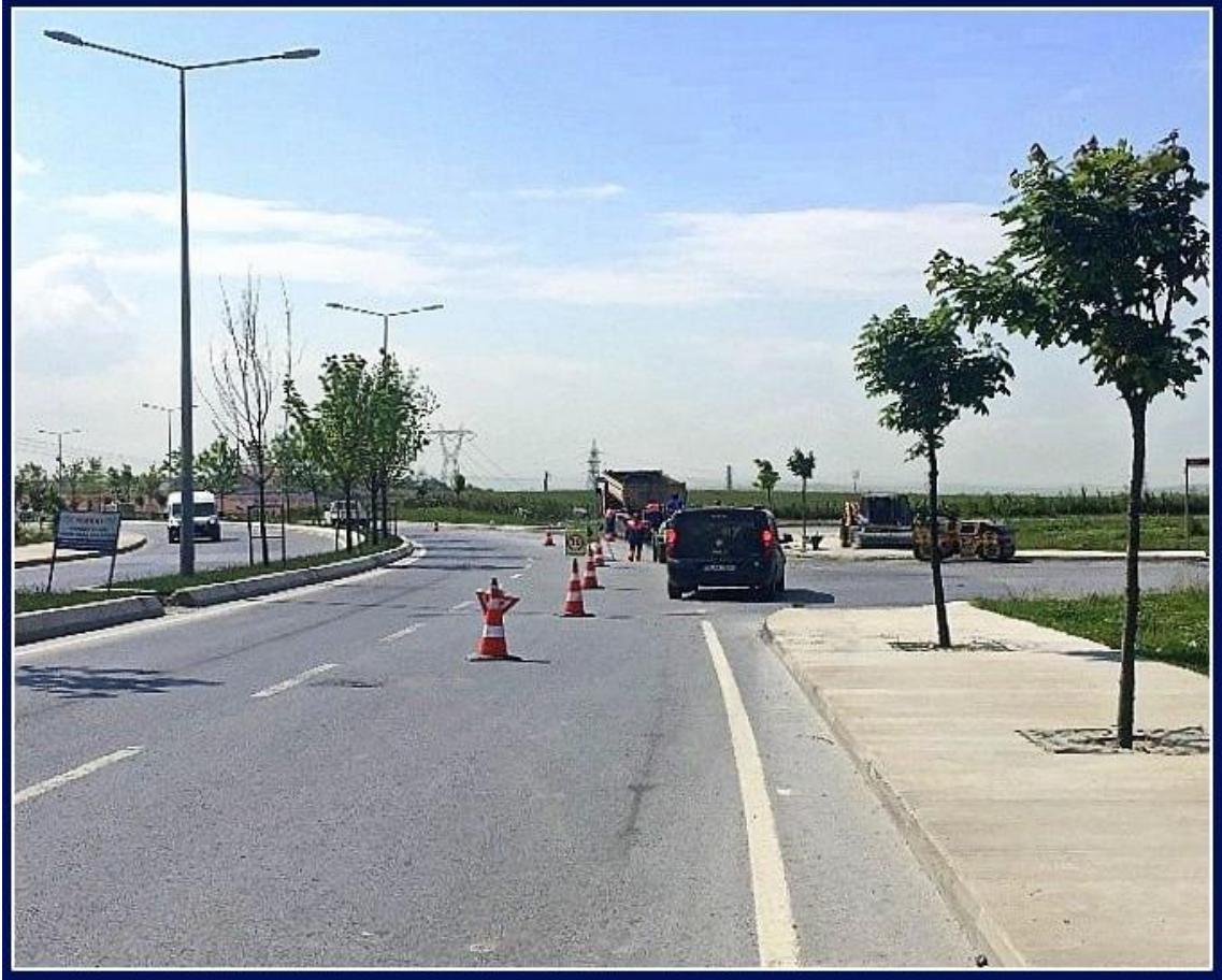
Resim 14; Arnavutk y evre yolu bakım onarım alıřması
