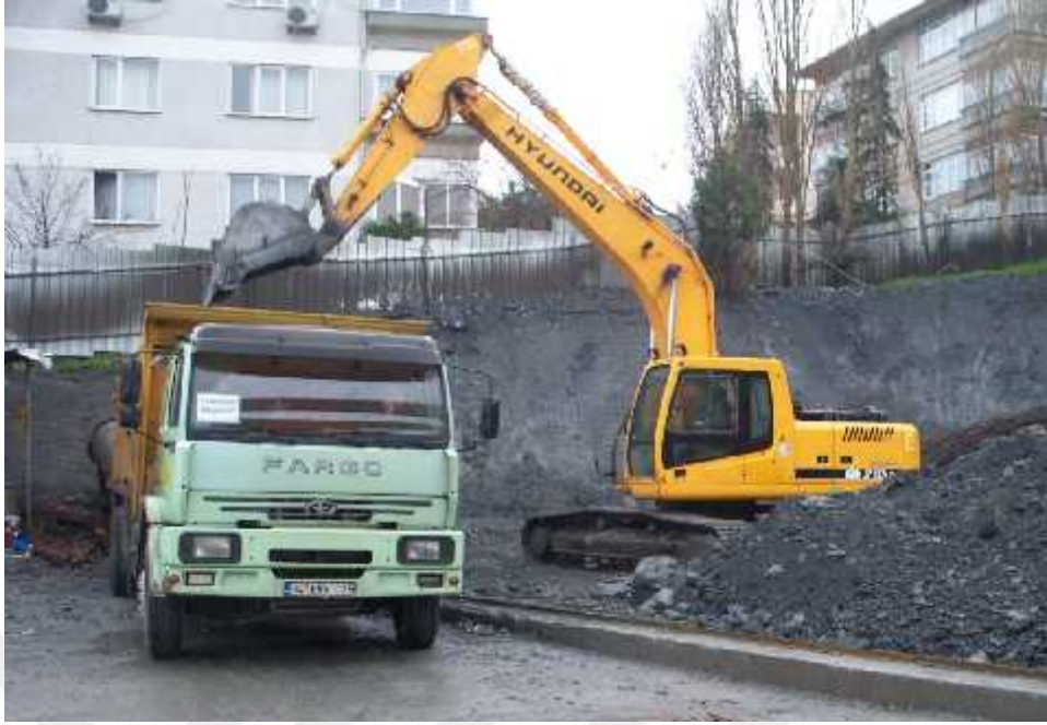
Resim 1- Yükleme esnasında hafriyat kamyonu ve onu yükleyen excavator
