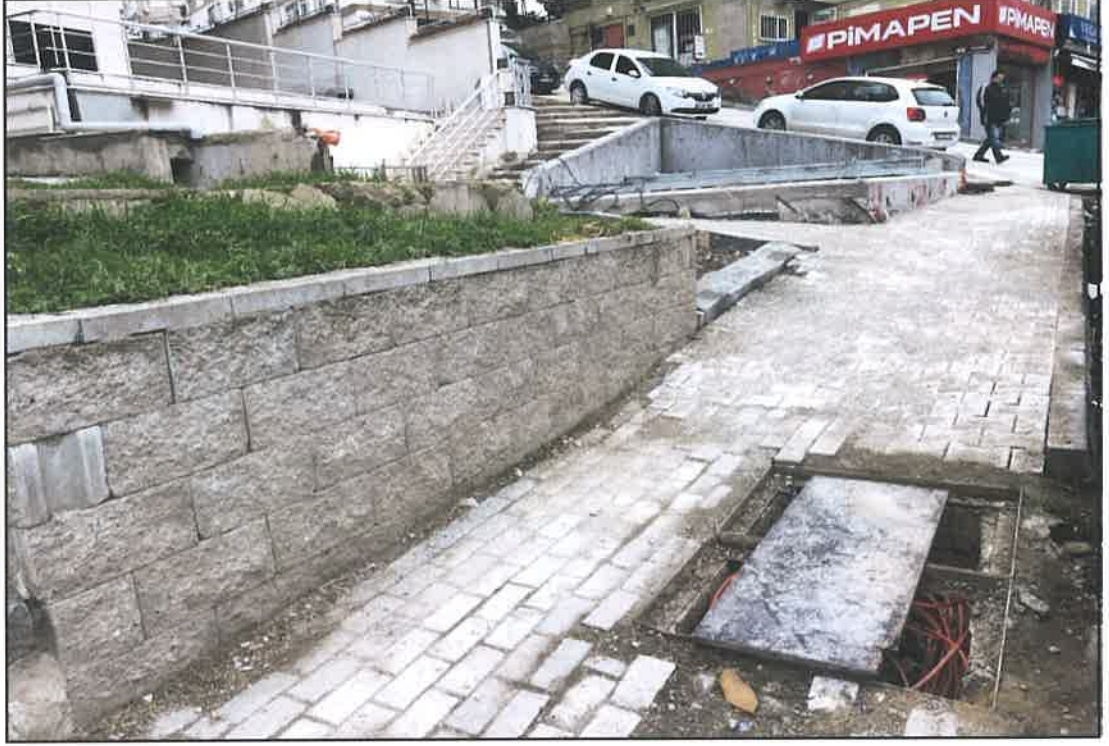
Resim 6.2: Elektrik Direkleri Ve Kutularının Kullanım
