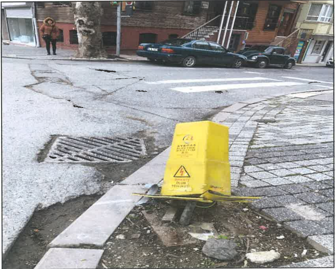
Resim 6.5: Elektrik Direkleri Ve Kutularının Kullanım
