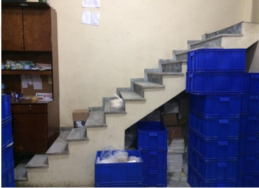
Resim 1: Ofis katına çıkan korkuluğu olmayan merdiven görseli
