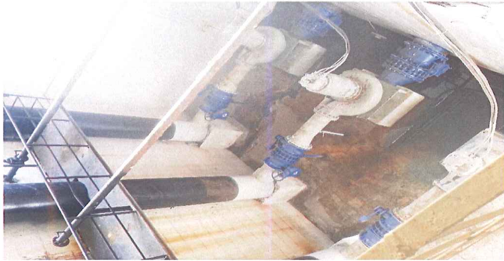
Resim 9: Mezitli Atıksu Arıtma Tesisi gürültü ölçümlerinin yapıldığı alanlar
