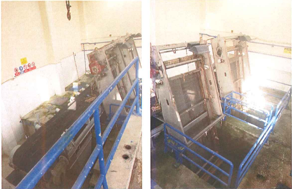
Resim 3: Batı Pompa İstasyonu'nun tarak kısımları
