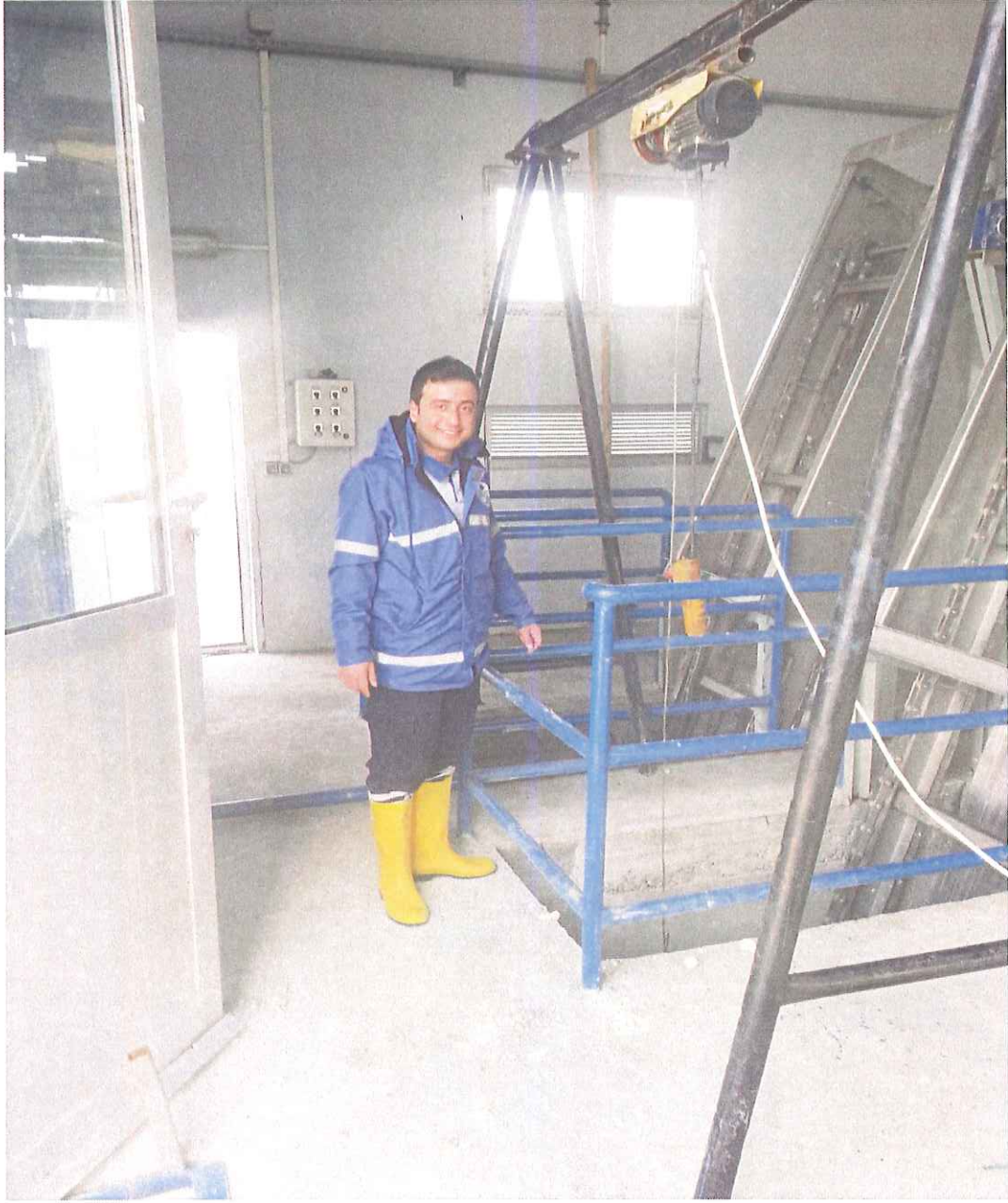
Resim 14: Çalışanın uygun olmayan iş çizmesi ile çalışması
