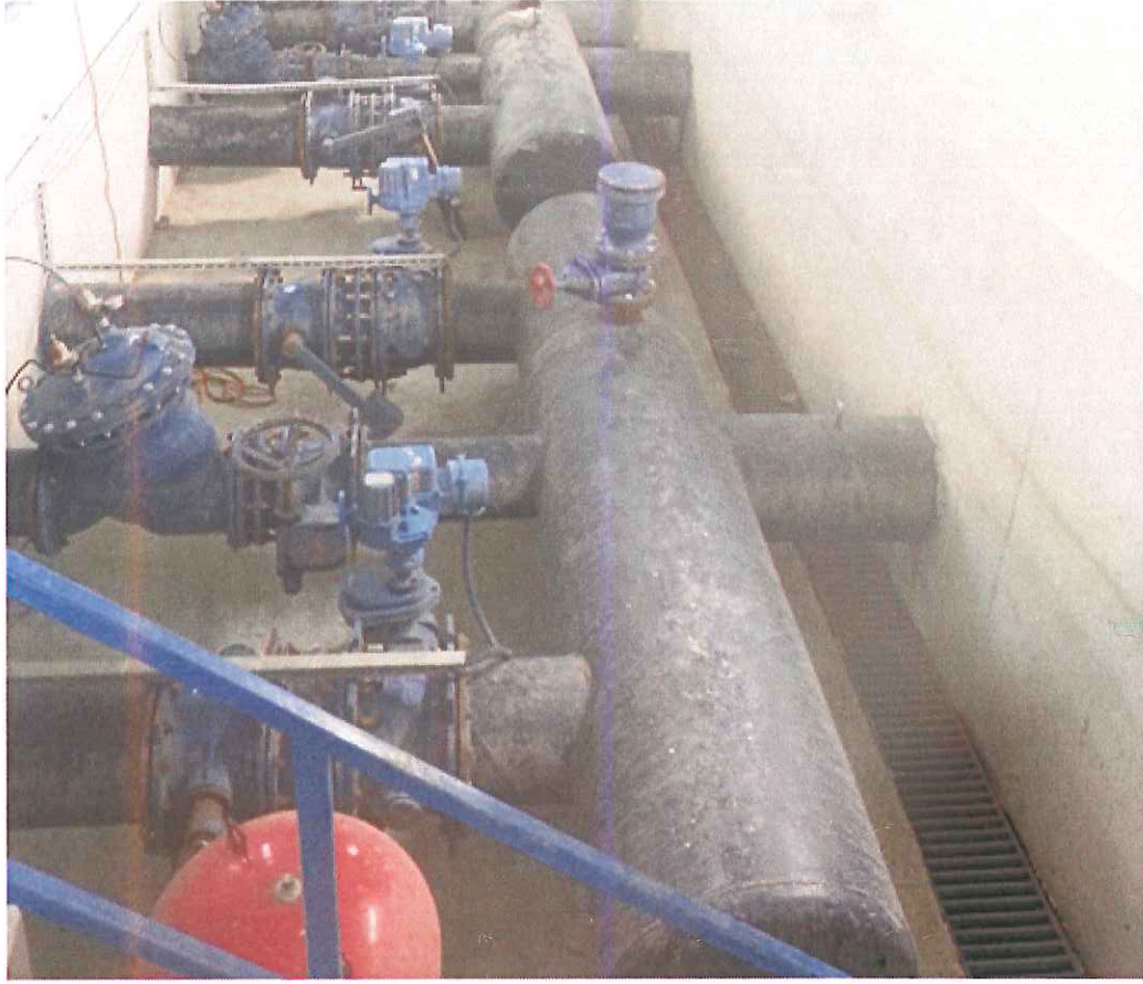
Resim 10: Merkez Pompa Atıksu Terfi İstasyonu gürültü ölçümlerinin yapıldığı alanlar
