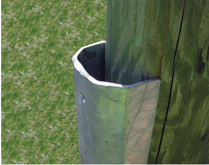
Resim 3: Ağaç direklerde mekanik hasar örneği
