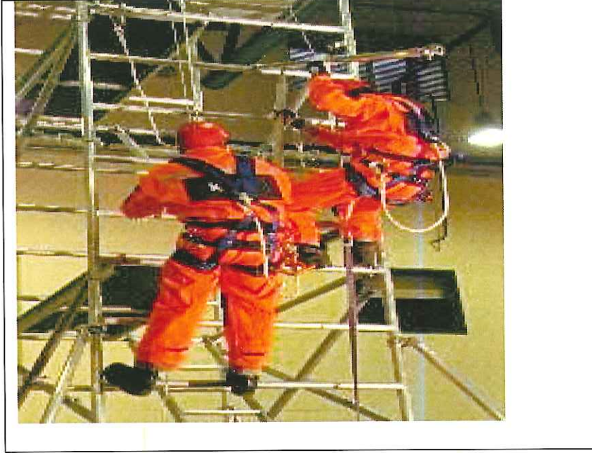
Resim 2.15. Kafes kiriş sistemi üzerinde tırmanma yapan bir çalışanın, düşey güvenlik halatına bağlanması
