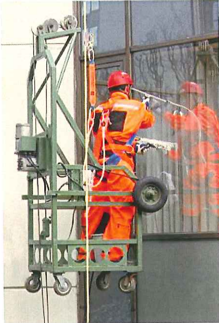
Resim 2.14. Yüksek Bir Binanın Camlarının Temizlenmesi İşinde Kullanılan Çalışanın Esnek/Hareketli Bir Ankraj Hattı Üzerinde Düşmeyi Önleme Tertibatı
