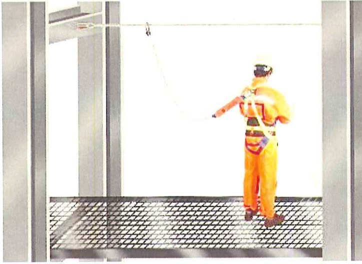
Resim 2.16. Yatay Yaşam Hattı ile Yüksekte Çalışma
