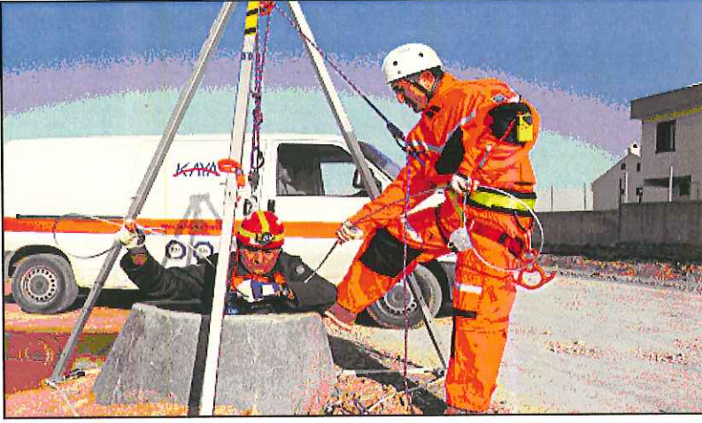
Resim 2.5. Üç Ayaklı Sehpa ile Kanalizasyon Çalışması
