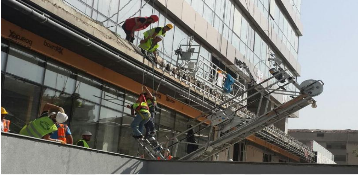
Resim 1: Yüksekten Düşen Çalışanın Askıda Kalması Durumu
