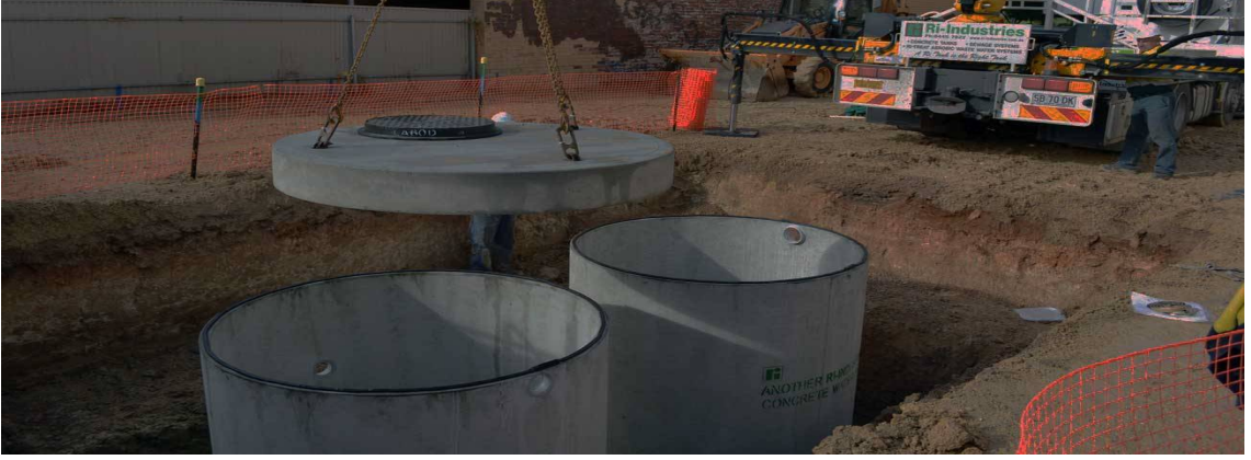
Resim 9 : Betonarme Foseptik Tank
