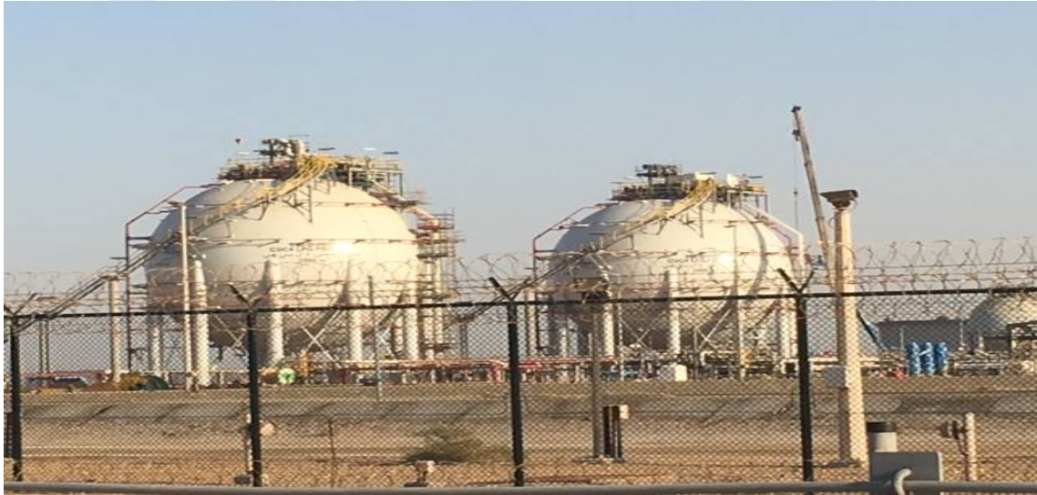
Resim 1: Çalışma Yapılan Tesisteki Kapalı Alan Örnekleri
