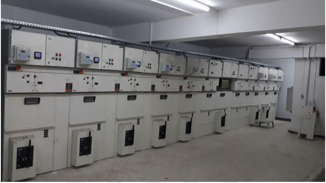
Şekil 24: Göynük DM-06 TR-01 Dağıtım Merkezi iç görünümü
