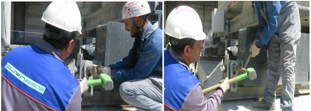
Şekil 20: Pim montajı
