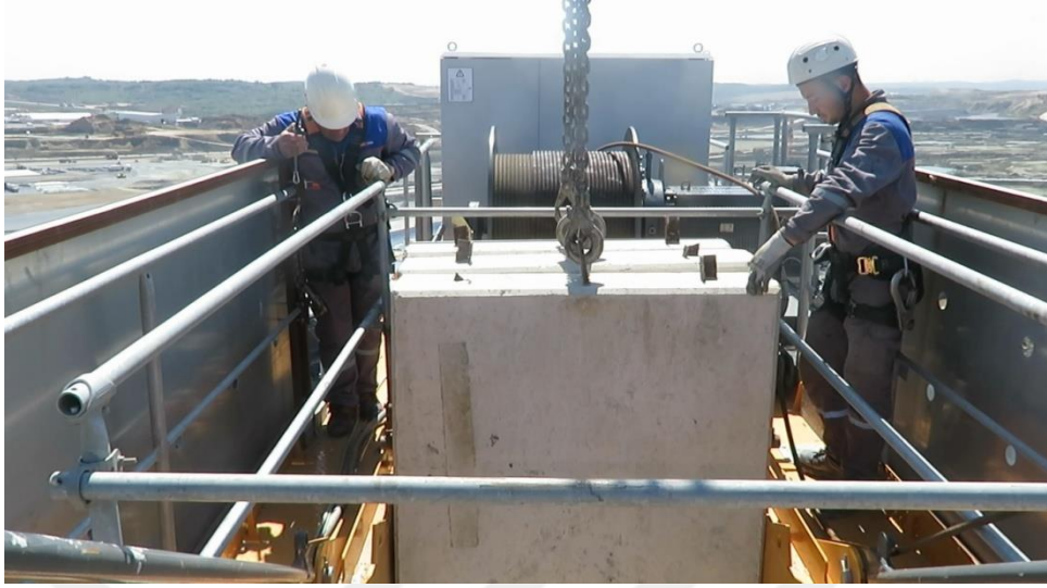
Şekil 25: Kuyruk grubu ağırlık taşlarının yerleştirilmesi
