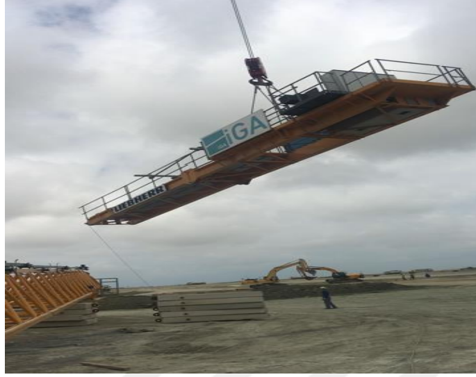
Şekil 31: Kuyruk grubu sökümü
