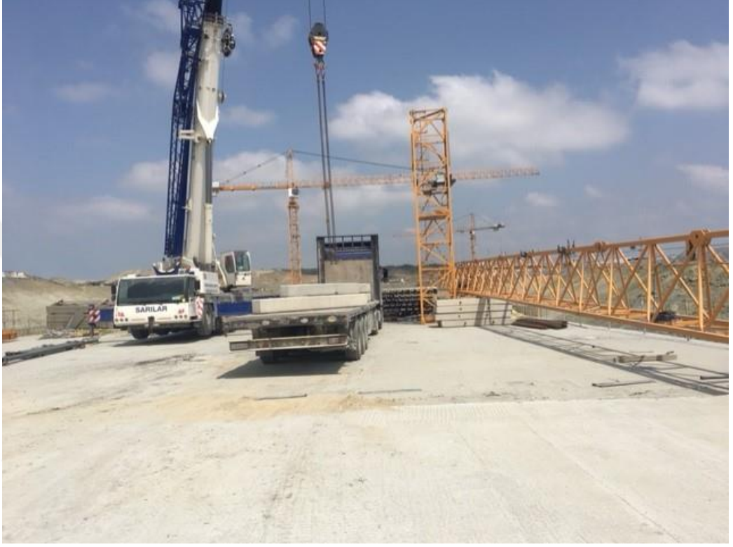
Şekil 33: Gövde sökümü
