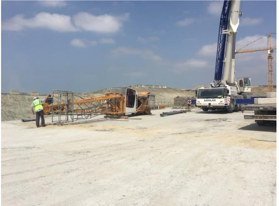
Şekil 32: Kabin sökümü
