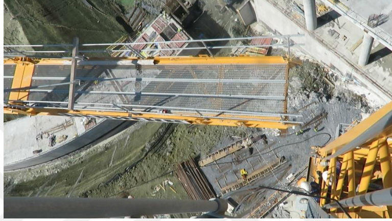
Şekil 24: Kule vinç kuyruğu montajı
