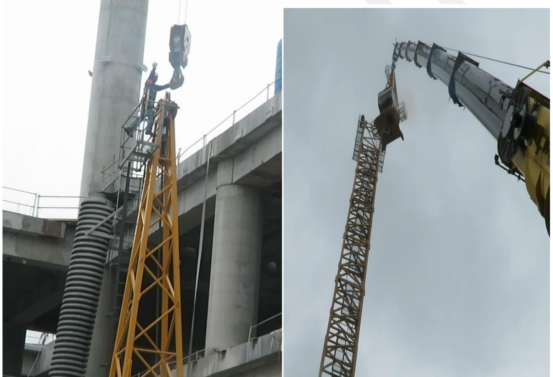
Şekil 23: Kabinin kancaya bağlanması ve montajı
