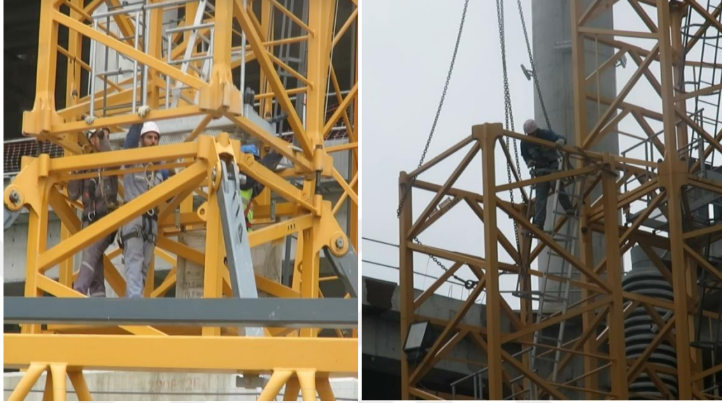
Şekil 21: Modül montajı
