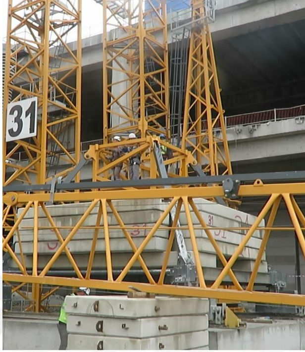
Şekil 20: Kule vinç tabanı ve denge ağırlıklarının yerleştirilmesi
