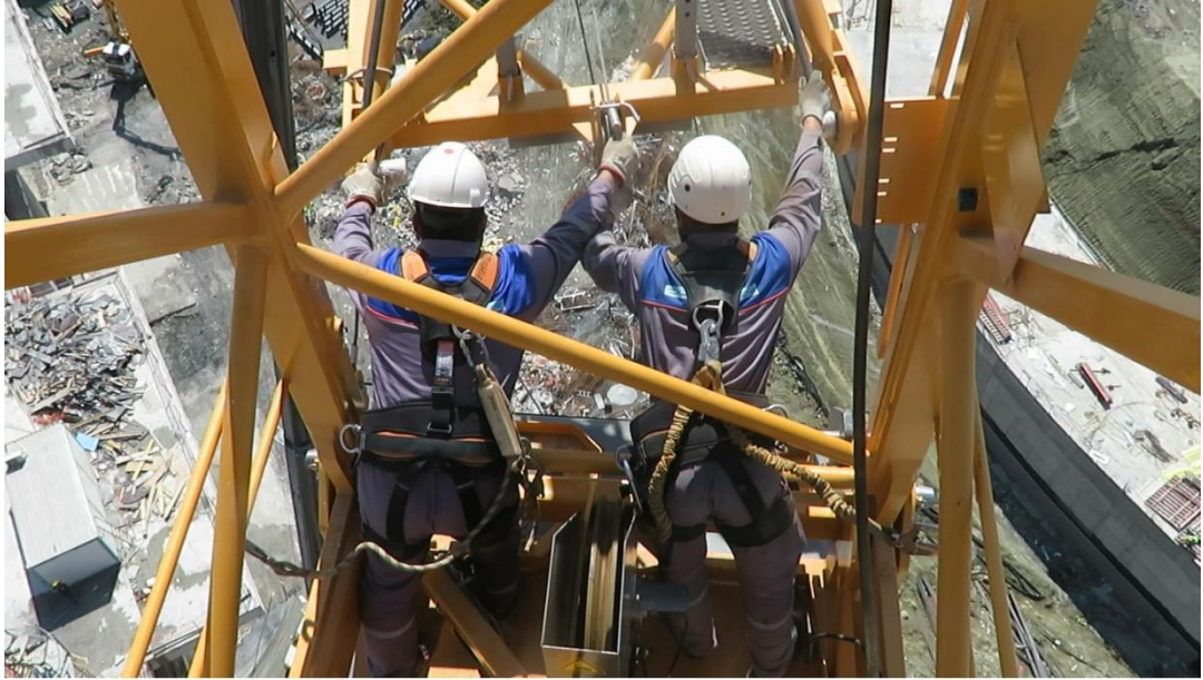
Şekil 26: Bom montajı
