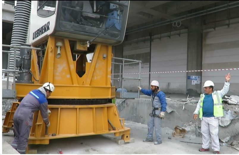
Şekil 22: Kabin kaldırma işlemi
